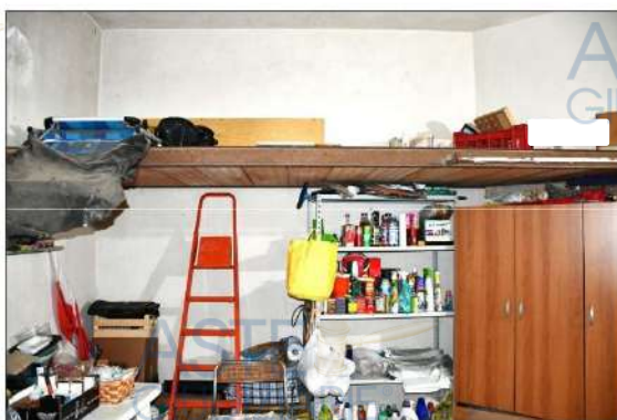
Foto 2 - Soppalco in ferro da smontare.
