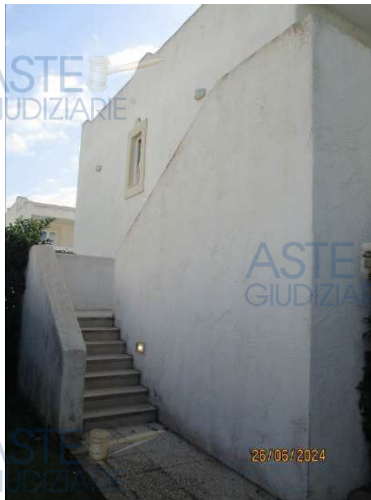
Foto n.3 – scala di accesso
