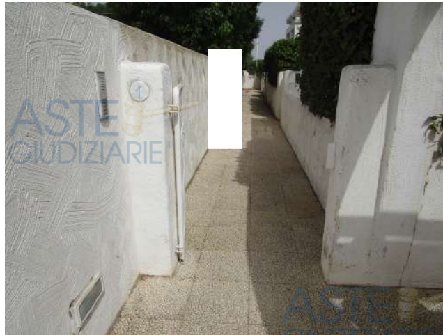
P.Ila 495 Sub. 19 – vialetto di ingresso del numero civico 1 (subalterni pignorati 2 e 5)
