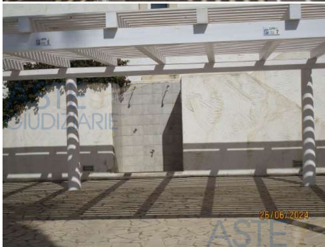
P.Ile 495/21 e 501/21 – vialetto retrostante i parcheggi e doccia esterna
