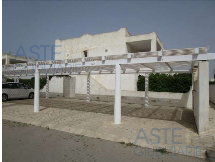
Vista di un edificio dalla via delle Dune
