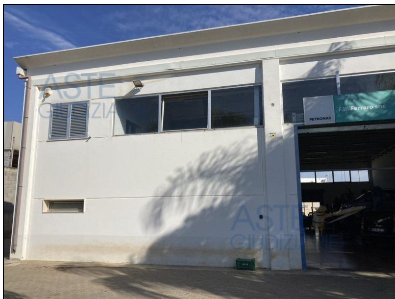
Foto n. 1 – Prospetto Sud (ingresso principale)
