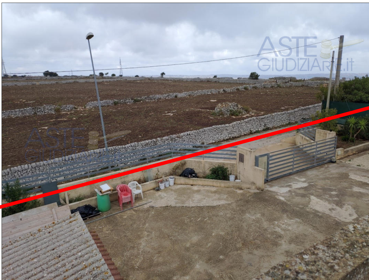
Ingresso al Cespite 2 in Contrada Porticatello snc. (Via dei Giacinti) - (foglio 172 particella 322)
