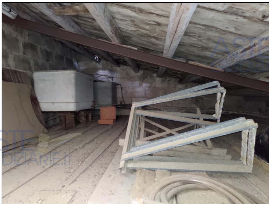
Sottotetto non abitabile.
