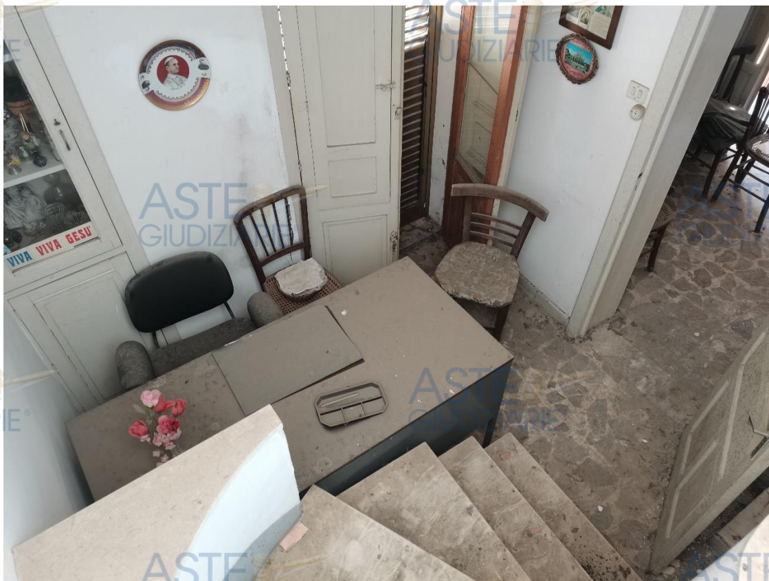
FOTO 11 – disimpegno-studio (piano primo)
