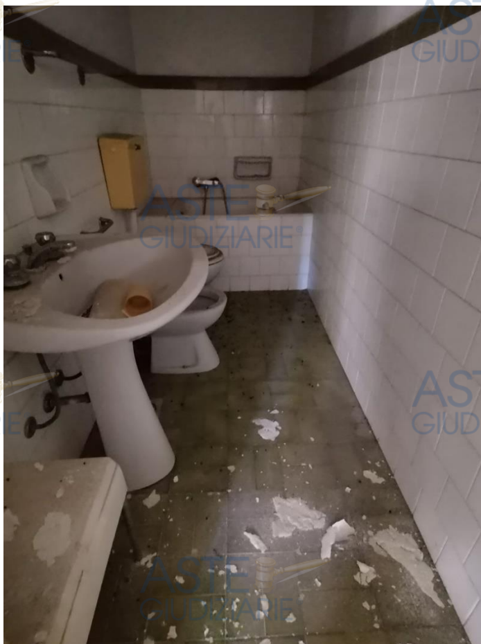
FOTO 9 – bagno 2 (piano primo)
