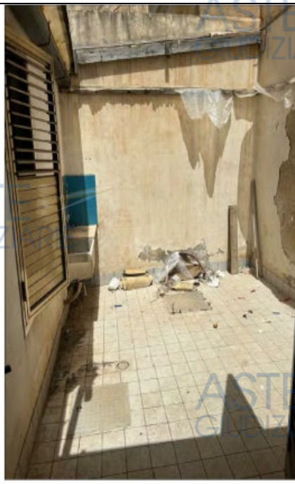
Vista del cortile sul retro
