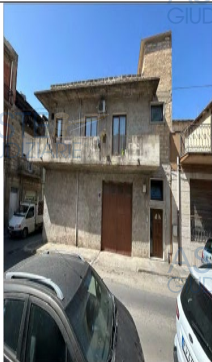
Vista del prospetto su Via dei Vespri
