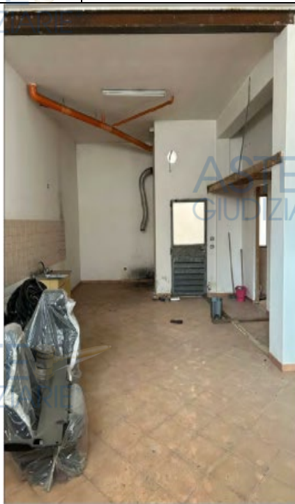
Vista del garage al piano terreno
