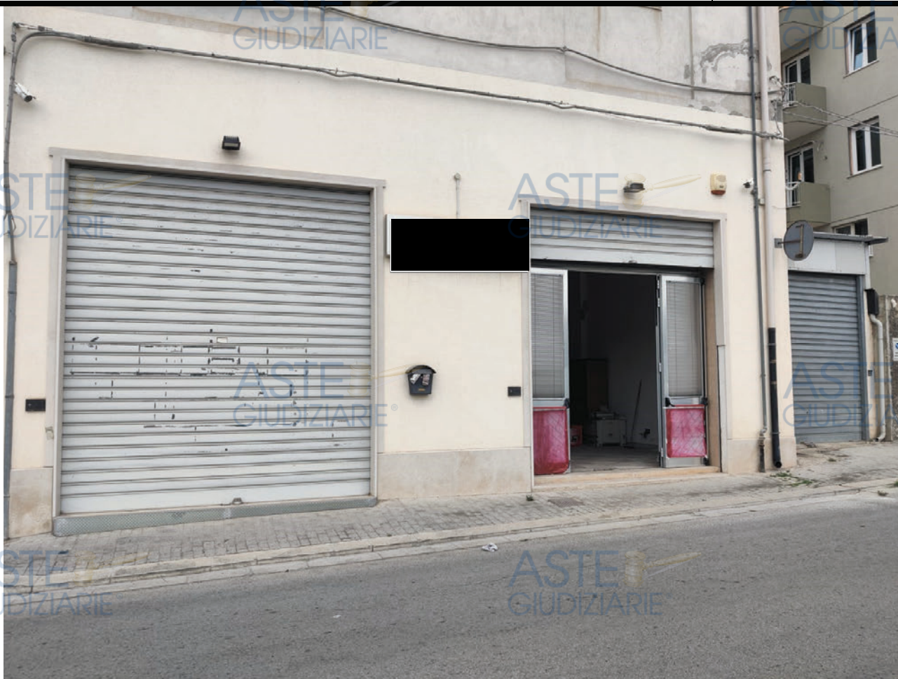
Prospetto principale su Via dei Lillà
