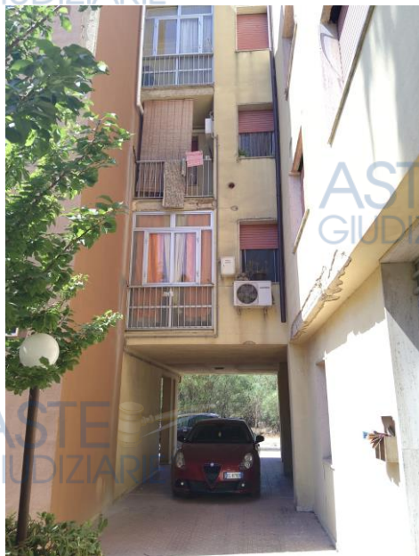
FOTO n. 2 PROSPETTO PRINCIPALE PROSPICIENTE SUL PIAZZALE
