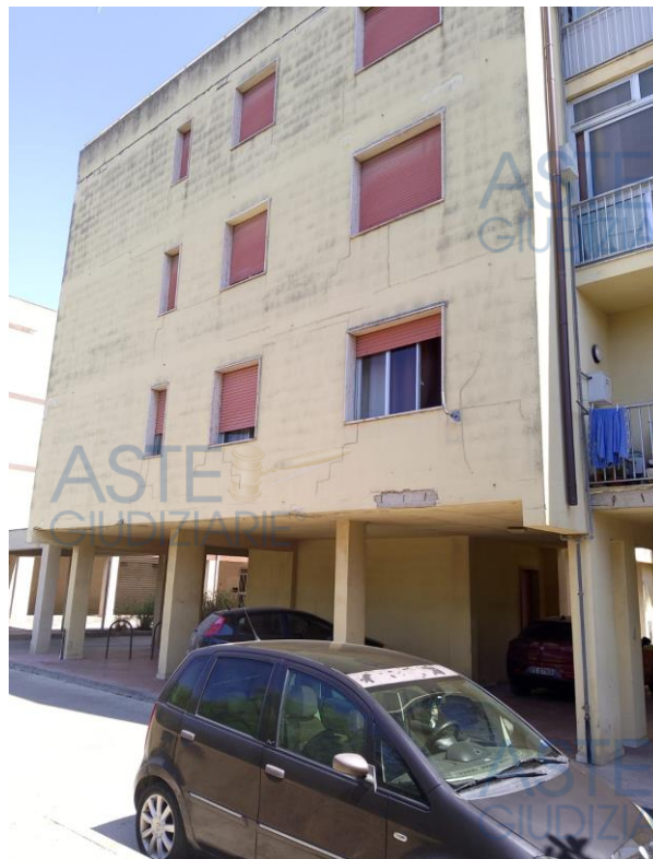
FOTO n. 4 PROSPETTO laterale APPARTAMENTO PIANO PRIMO
