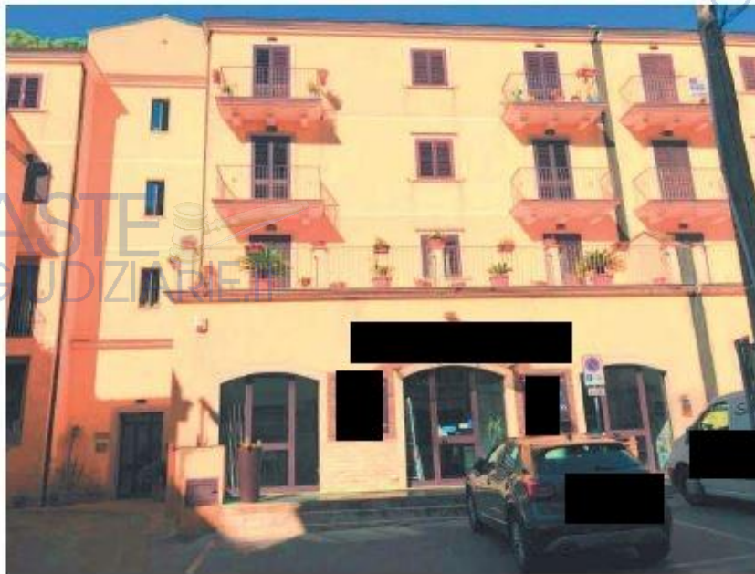
Foto n°11 – Prospetto su via Modica Sorda 99
