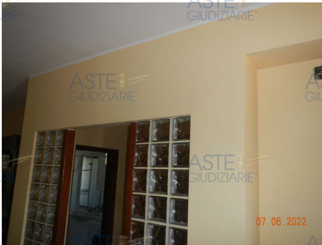
Parete in vetro-mattone di accesso alla Cucina
