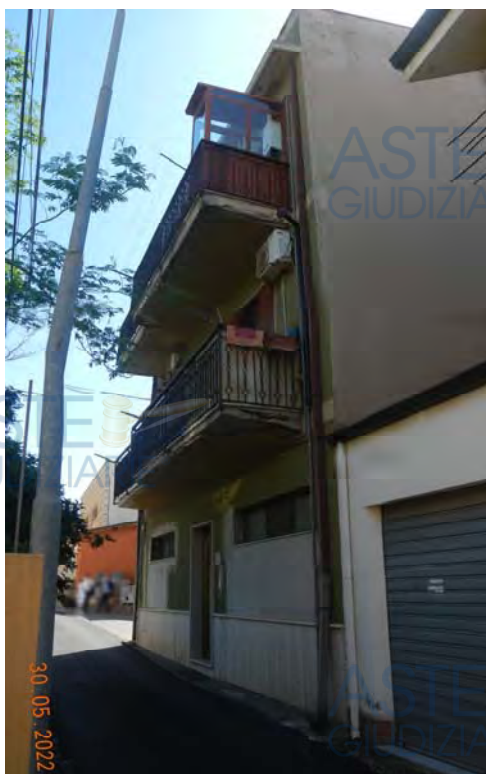
Prospetto prospiciente la strada di Via Patera
