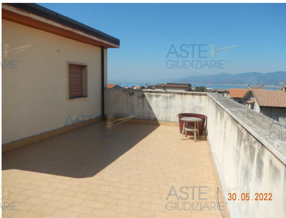
Parapetto e finestra corrispondente al locale deposito
