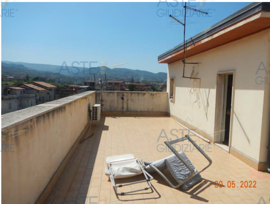
Uscita sul terrazzo - pavimentazione
