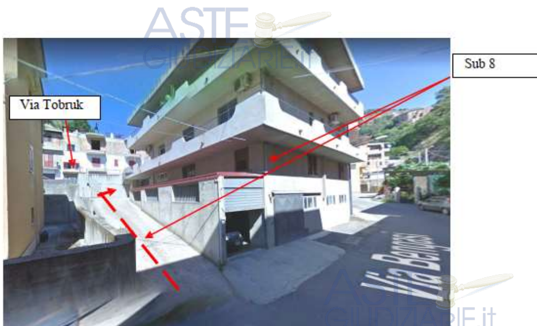
Fig. 3 Rampa di Accesso da Via Bengasi
