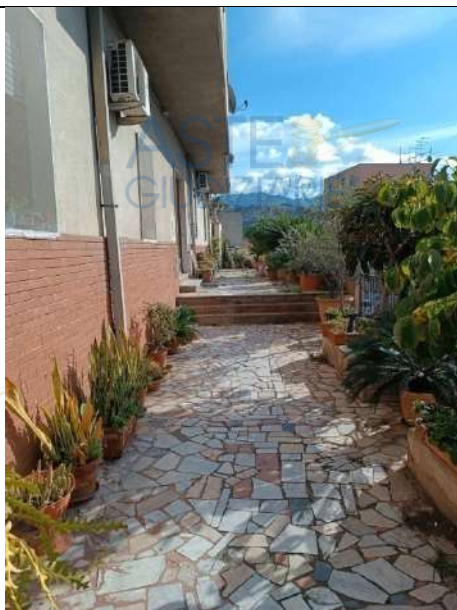
Foto 8. Particolare del cortile che consente di accedere al portone di accesso al vano scala del fabbricato
