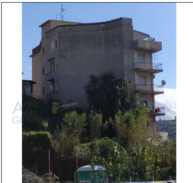
Foto 5. Vista esterna del fabbricato, prospetto principale Ovest
