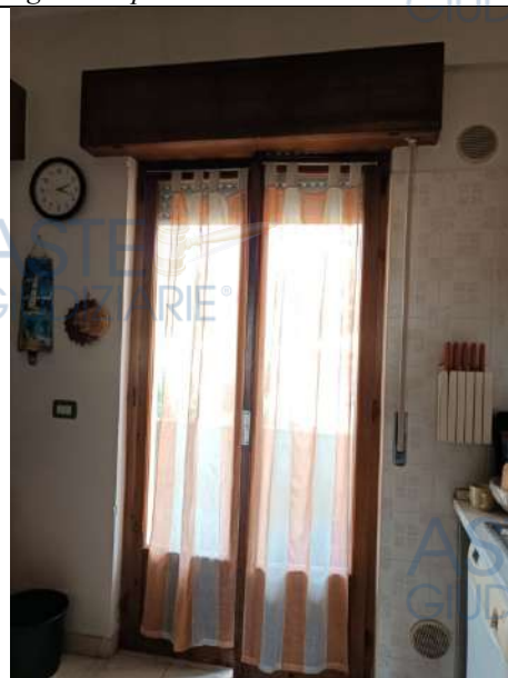
Foto 48. Particolare della tipologia di finestra interna ad un'anta, in legno, vetro singolo, con avvolgibile in pvc
