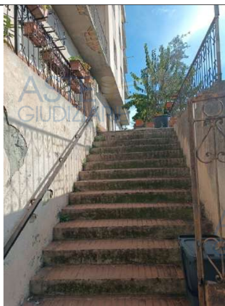
Foto 7. Particolare della rampa di scale che consente di raggiungere il cortile per l'accesso alla scala che serve i vari livelli del fabbricato
