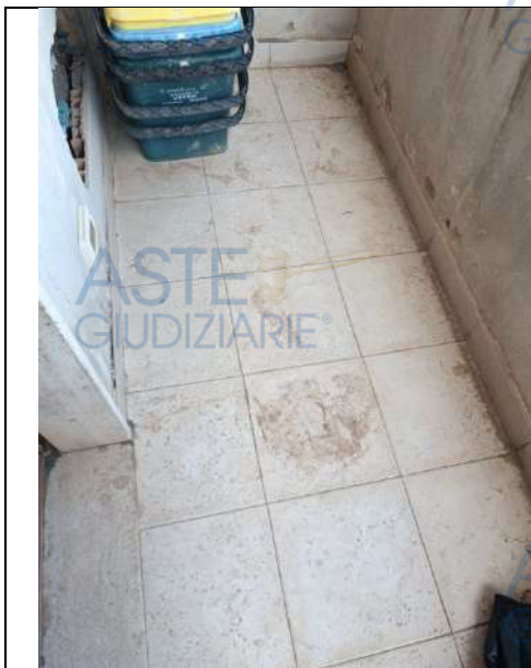
Foto 55. Particolare della tipologia di pavimentazione, in piastrelle di ceramica, presente sul balcone posto sul lato Nord
