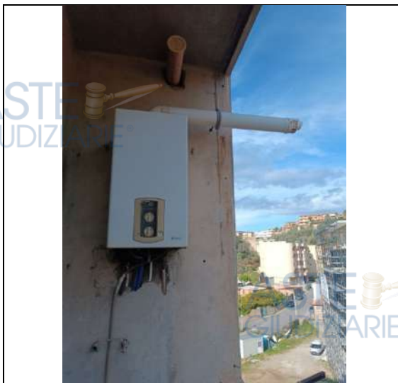
Foto 21. Vista del presente scaldino per l'acqua calda sanitaria, posto sul balcone lato Nord
