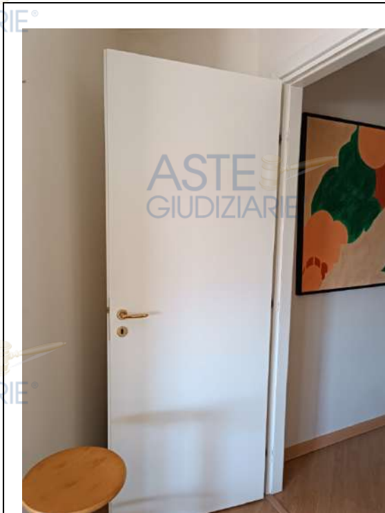
Foto 47. Particolare della tipologia di porta interna, in legno tamburato
