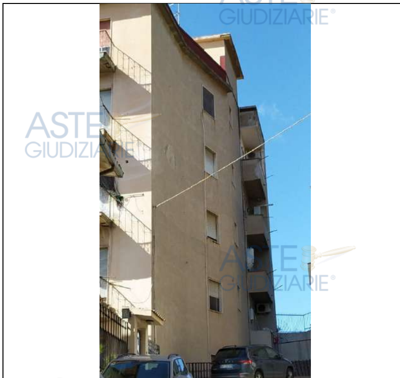
Foto 4. Vista esterna del fabbricato, prospetto principale Nord
