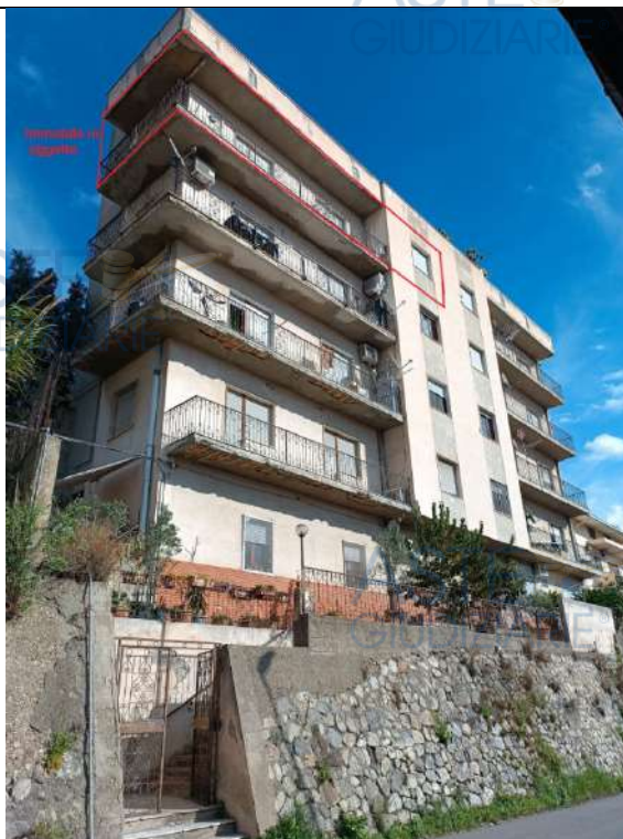
Foto 2. Vista esterna del fabbricato, prospetto principale Sud
