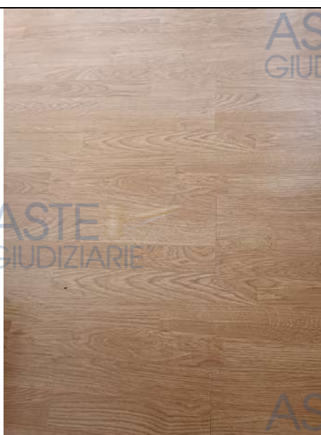
Foto 54. Particolare della tipologia di pavimentazione in laminato, presente in tutti gli altri ambienti.
