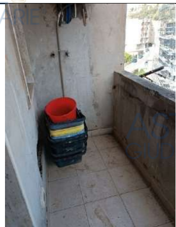
Foto 46. Vista del balcone Nord-Est, a servizio della cucina
