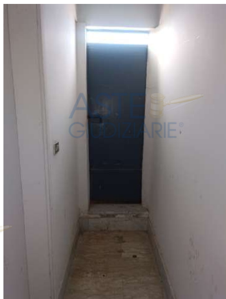
Foto 57. Vista del corridoio dell'abbaino di accesso alla terrazza
