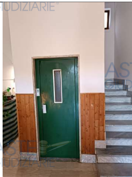
Foto 11. Particolare del presente ascensore e della prima rampa di scala del fabbricato
