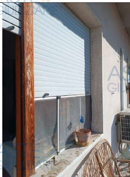
Foto 52. Particolare della tipologia di avvolgibili in pvc
