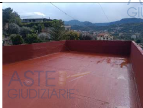
Foto 60. Vista della terrazza, lato Sud-Est
