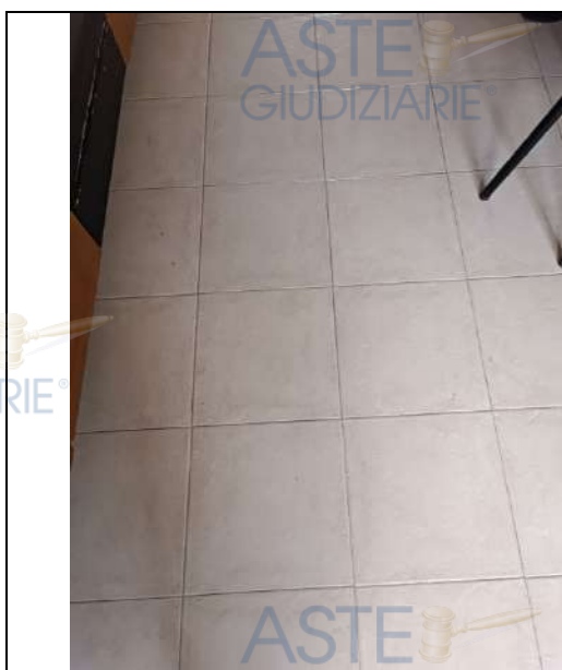
Foto 53. Particolare della tipologia di pavimentazione, in piastrelle di ceramica, presente nella cucina
