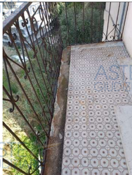
Foto 56. Particolare della tipologia di pavimentazione, in piastrelle di ceramica, presente sul balcone posto sul lato Sud
