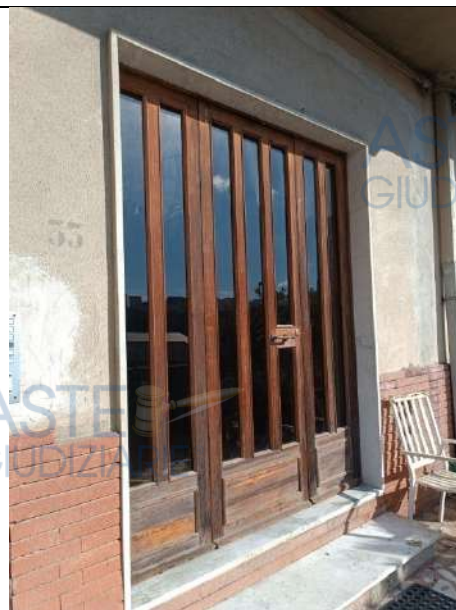
Foto 9. Particolare del portone d'ingresso del vano scala
