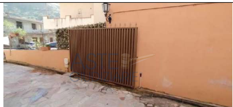
Foto 7. In Alto: Vista del cortile di accesso alla scala del fabbricato che serve i beni oggetto di pignoramento ai subb. 3,4, 5, 8 e 9
