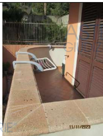
Foto 56. Vista del balcone esclusivo che serve la camera 2
