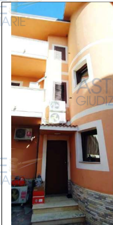
Foto 6. Particolare del portone di accesso alla scala del fabbricato dove sono presenti i beni oggetto di pignoramento ai subb. 3, 4, 5, 8 e 9
