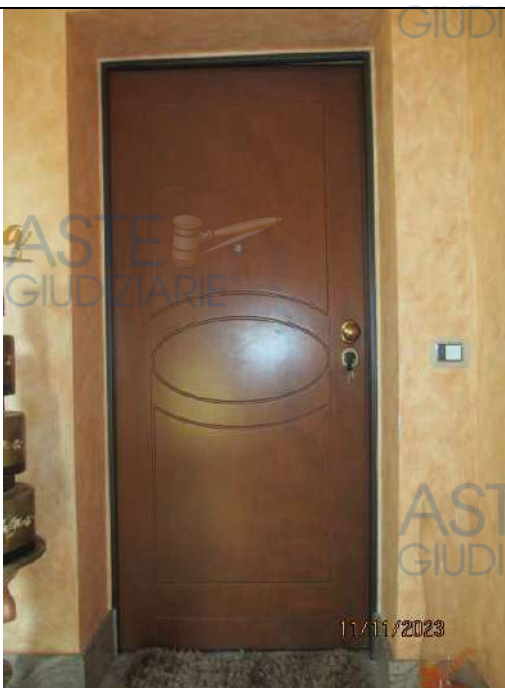
Foto 12. Particolare della tipologia di portone blindato di accesso al bene posto al piano primo, sub 5, oggetto di pignoramento
