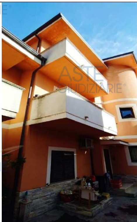
Foto 4. Vista esterna del fabbricato, prospetto laterale Sud
