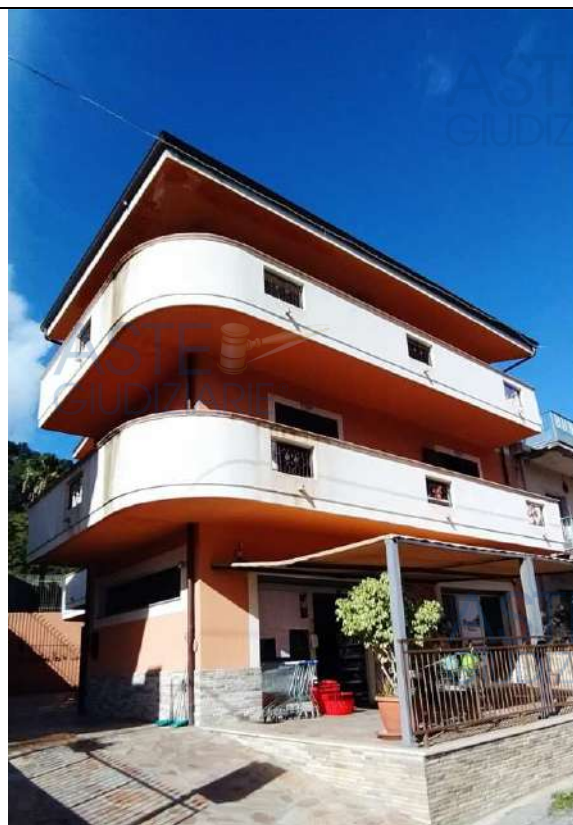
Foto 3. Vista esterna del fabbricato, prospetto principale Est
