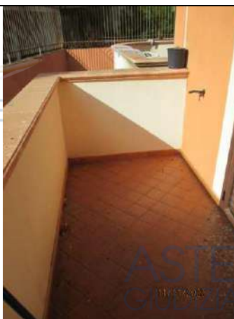
Foto 55. Vista del balcone esclusivo che serve la camera 1
