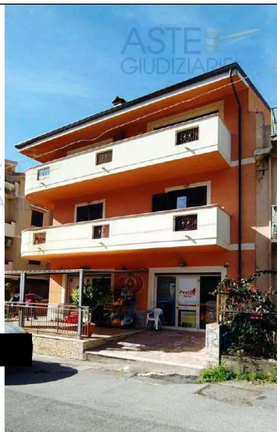
Foto 2. Vista esterna del fabbricato, prospetto principale Est
