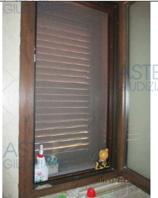
Foto 62. Particolare della tipologia di finestra in legno a vetro doppio
