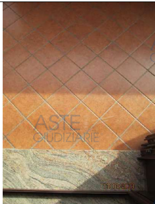
Foto 84. Particolare della pavimentazione dei balconi
