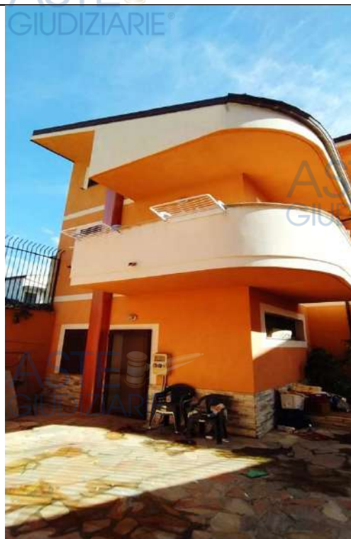
Foto 5. Vista esterna del fabbricato, prospetto posteriore Ovest
