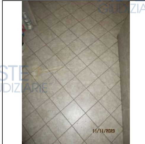
Foto 65. Particolare della tipologia di pavimentazione, in piastrelle di ceramica, presente nel bagno 1
