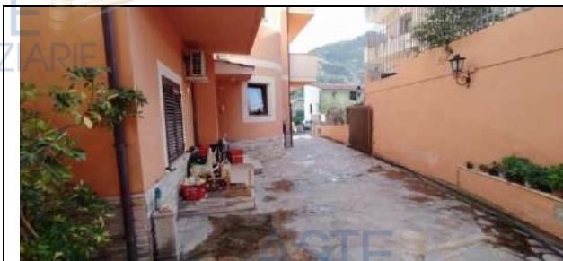
Foto 97. Particolare della corte comune al fabbricato, posta a Sud
