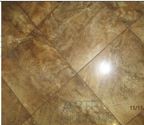
Foto 63. Particolare della tipologia di pavimentazione, in gress porcellanato, presente nell'immobile, al piano primo
