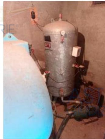
Foto 15 e 16. Particolari del motore dell'impianto autoclave
