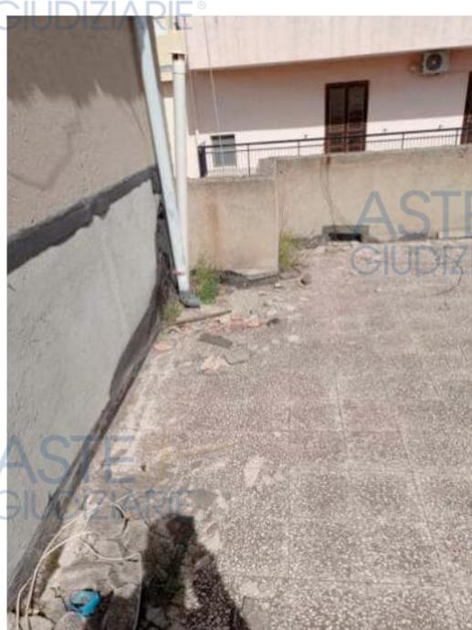
Foto 62 e 63. Particolari dei danni rilevati in terrazza, dove si osservano parapetti crepati ed assenza di impermeabilizzazione, nonché depositi di materiale inerte, ovunque
