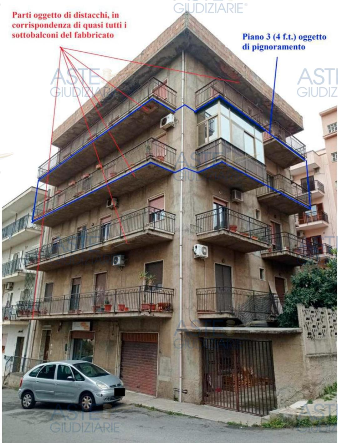
*Foto 56. Prospetto principale e laterale (quest'ultimo non oggetto di spicconamento da parte dei Vigili del Fuoco) dove si denotano le parti immediatamente pericolanti del fabbricato*
