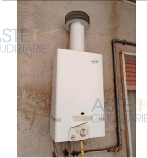
Foto 21. Vista del presente scaldino per l'acqua calda sanitaria
