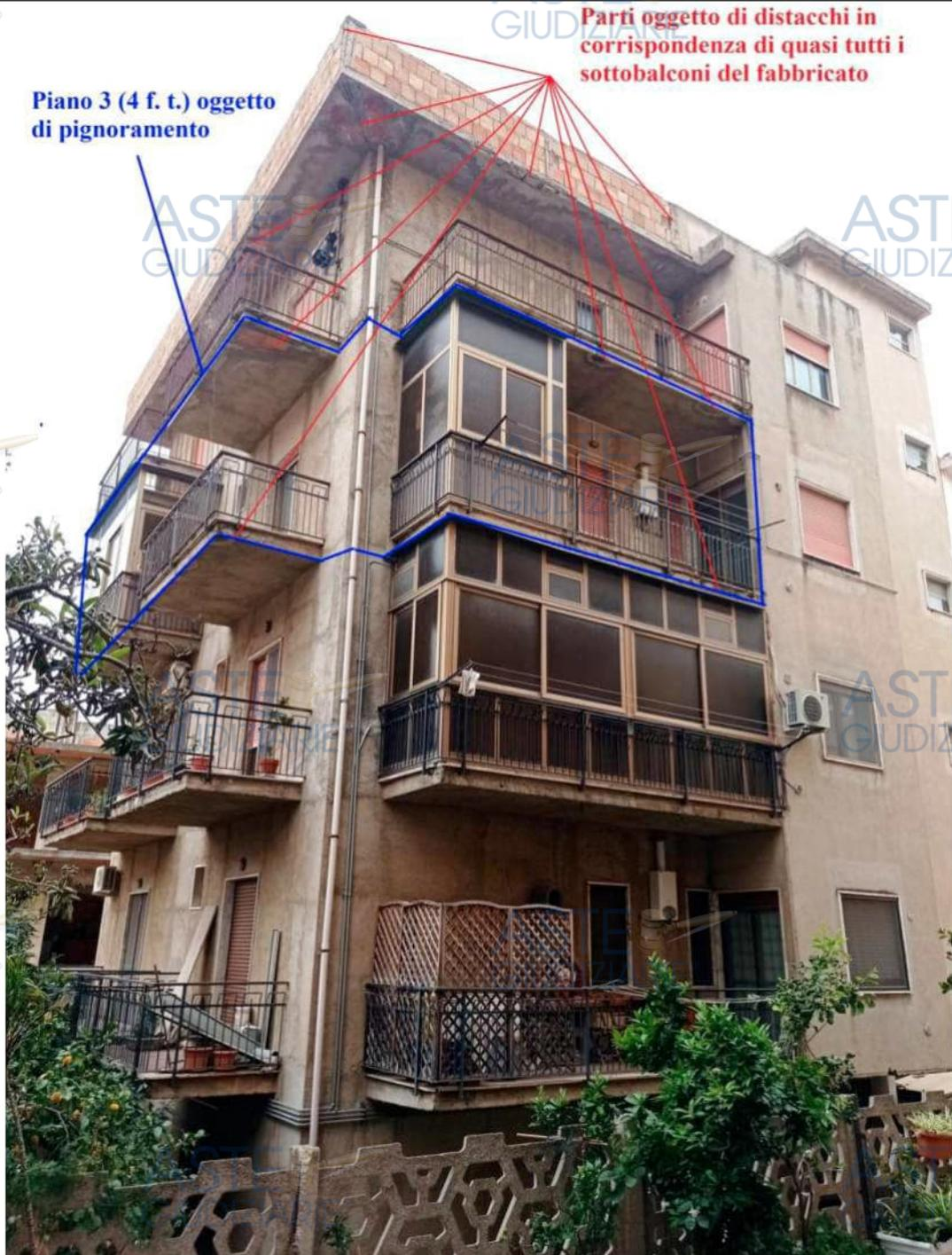
*Foto 57. Prospetto laterale dove si denotano le parti immediatamente pericolanti del fabbricato che non sono state oggetto di spicconamento da parte dei Vigili del Fuoco*
