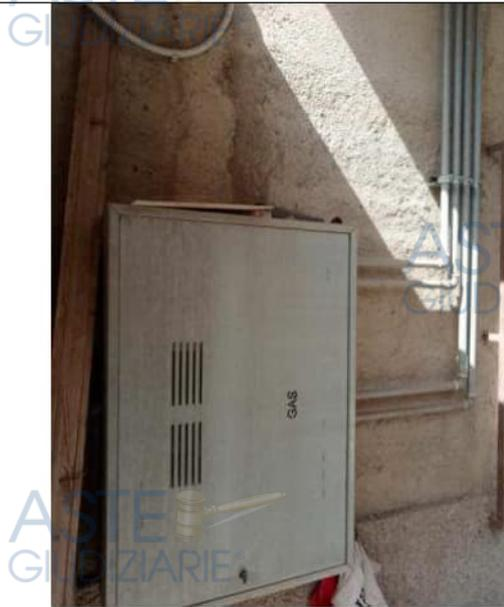
Foto 17. Particolare dei contatori gas metano, posti all'esterno del fabbricato, che servono i vari appartamenti
