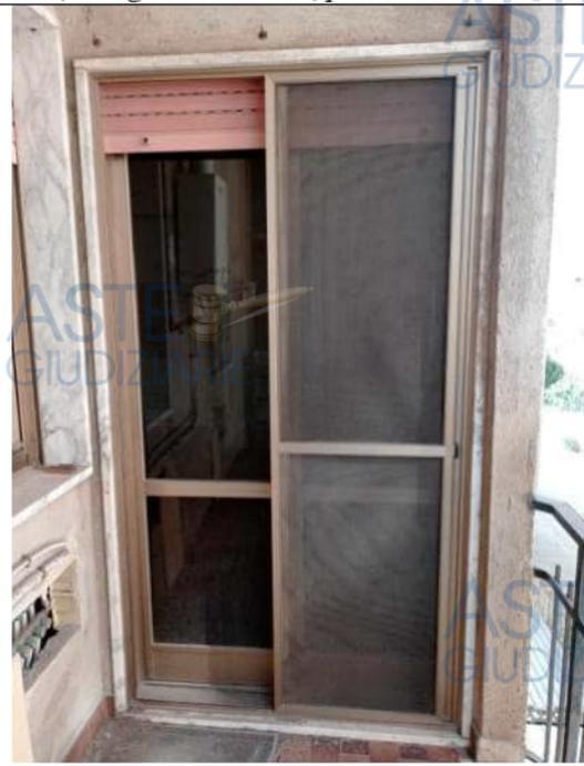
**Foto 42.** Particolare della tipologia di finestra, in alluminio, ad un'anta, vetro singolo, con avvolgibile in PVC
