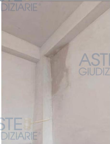
Foto 58 e 59. Particolari dei danni riscontrati sulle superfici dell'abbaino, in corrispondenza del tetto e delle pareti
