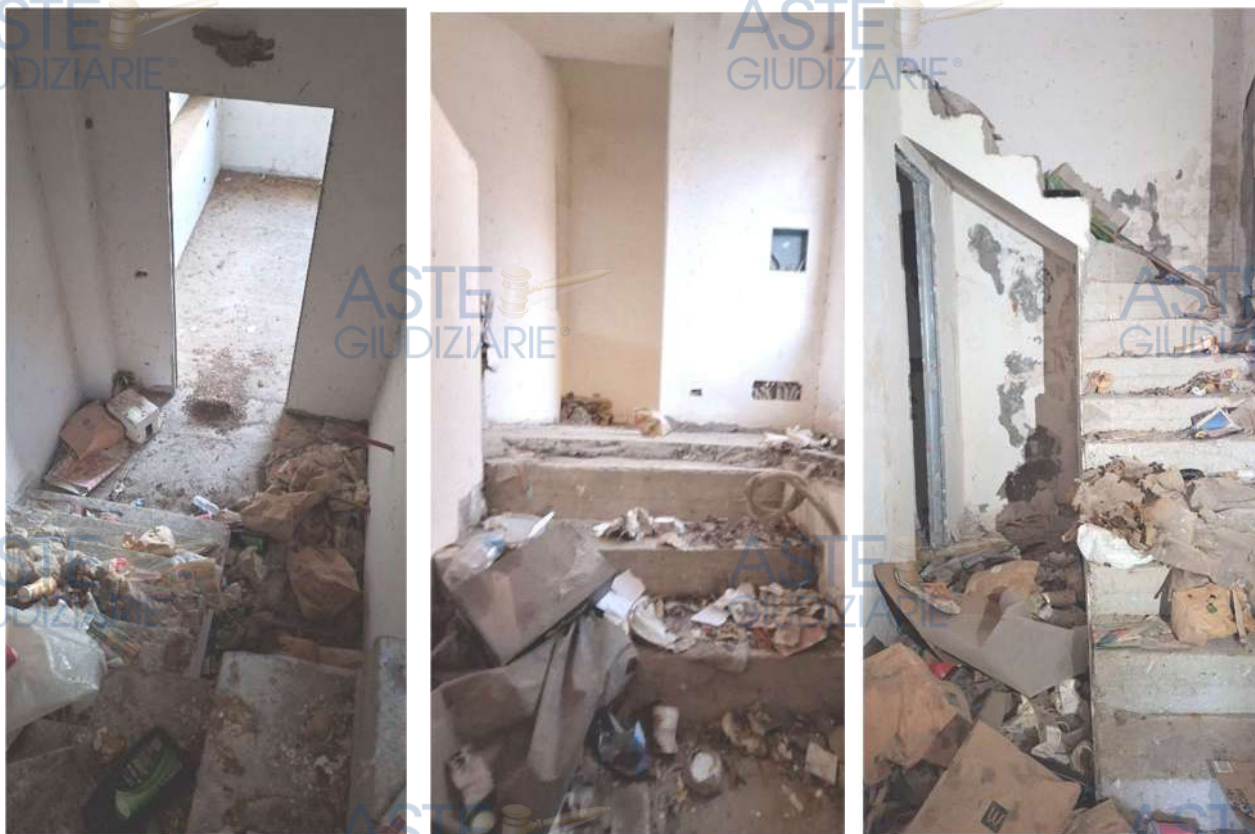
Vista della scala in c.a. che collega piano terra e piano seminterrato con vista della porta ripostiglio
