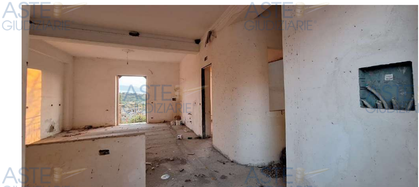
Piano terra vista del salone e della porta di disimpegno verso la cucina, bagno e camera.
