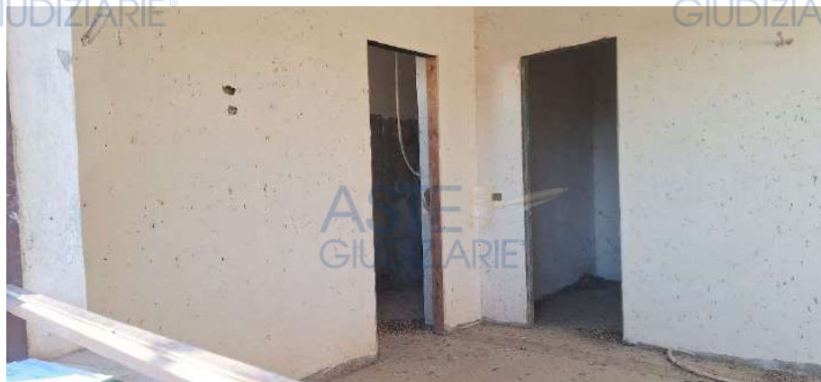
Vista della porta della cabina armadio e del bagno al piano seminterrato
