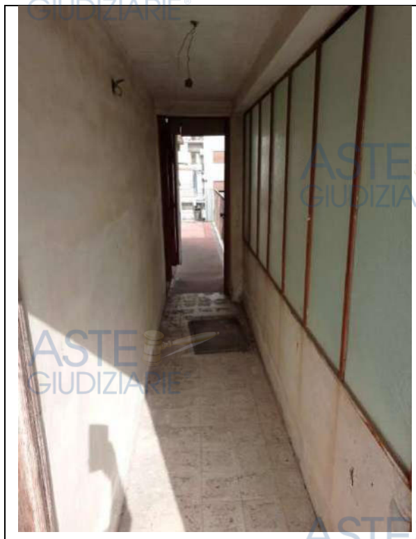
Foto 77. Vista del Corridoio
