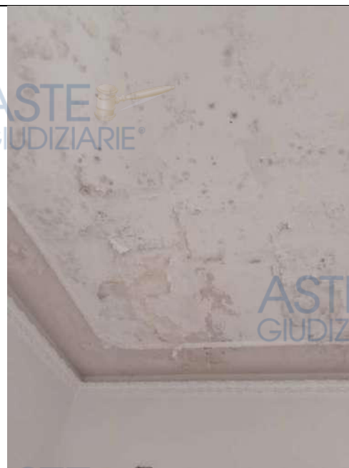
Foto 67. Particolari dei problemi di defogliazione della pittura ed ammaloramento da infiltrazione di acqua proveniente dalla terrazza, presenti al piano Terzo
