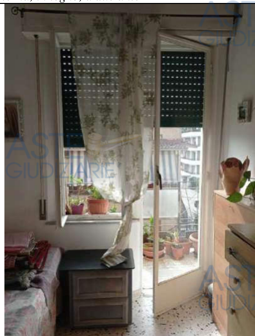
Foto 54. Particolare della tipologia di finestra e porta-finestra, in ferro, a due ante con avvolgibili in pvc
