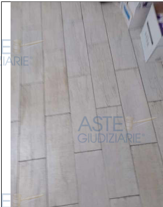
Foto 38. Particolare della tipologia di pavimentazione, in piastrelle di ceramica, presente nell'immobile, al piano Terra
