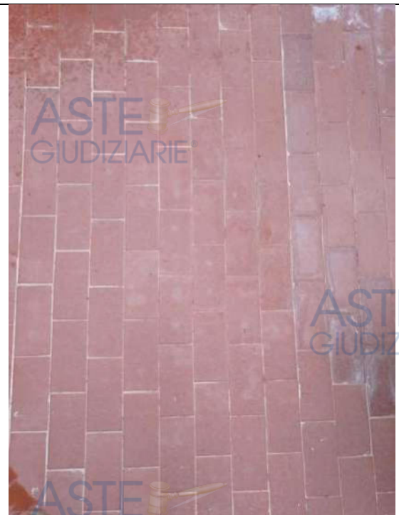
Foto 39. Particolare della tipologia di pavimentazione, in piastrelle di ceramica da esterno, presente nell'immobile, al piano Terra, nel cortile
