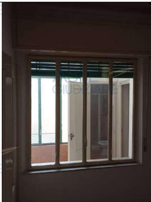
Foto 61. Particolare della tipologia di finestra, in ferro, a quattro ante, vetro singolo, con avvolgibile in pvc
