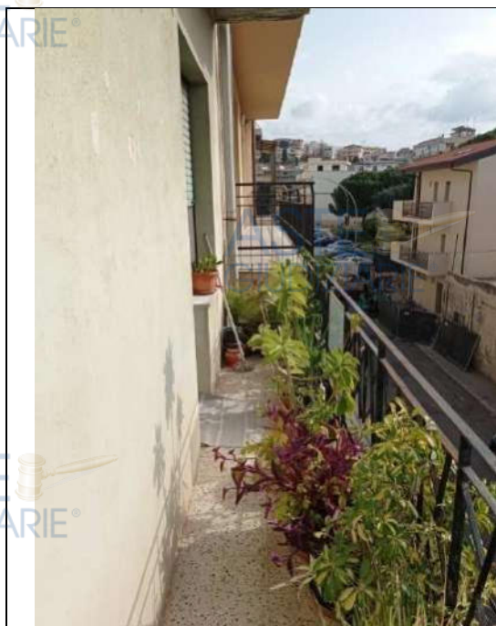
Foto 49. Vista del Balcone Sud
