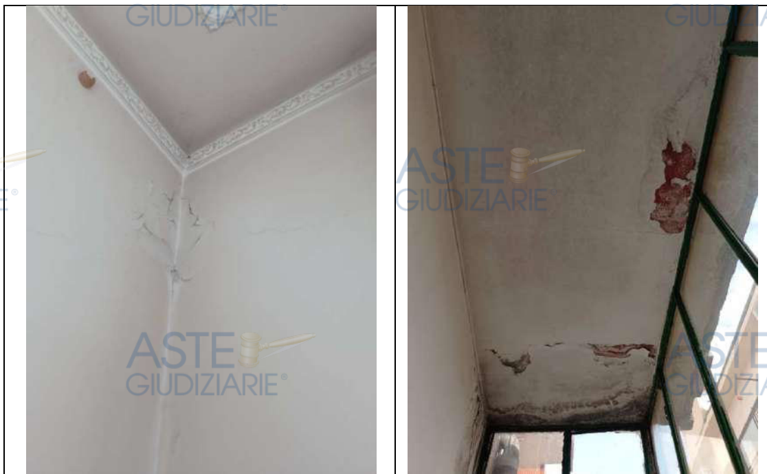
Foto 69. Particolari dei problemi di defogliazione della pittura ed ammaloramento da infiltrazione di acqua proveniente dalla terrazza, presenti al piano Terzo
