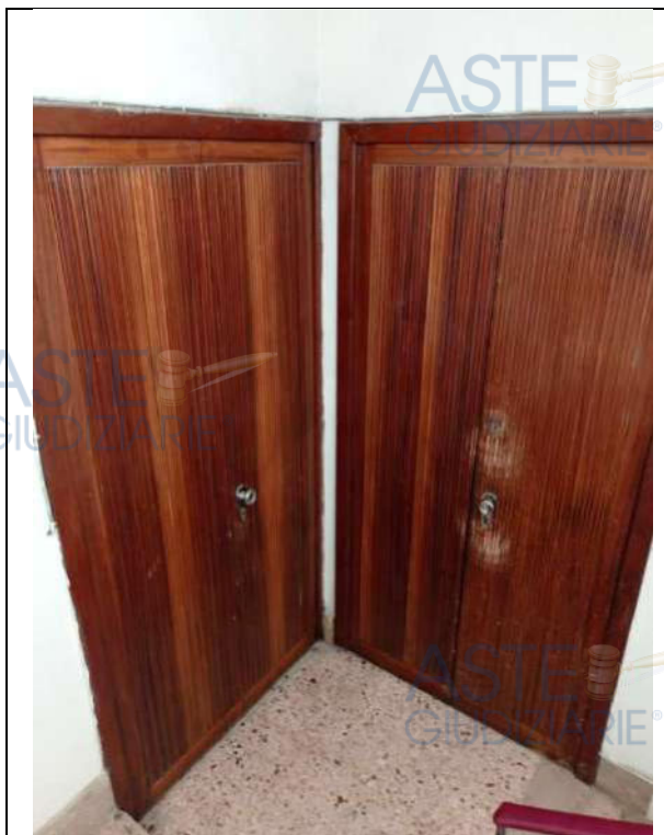
Foto 58. Particolare del doppio ingresso, al piano Terzo
