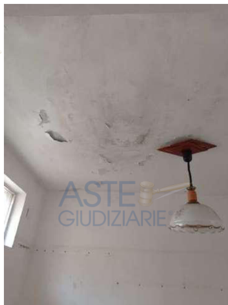
Foto 67. Particolari dei problemi di defogliazione della pittura ed ammaloramento da infiltrazione di acqua proveniente dalla terrazza, presenti al piano Terzo
