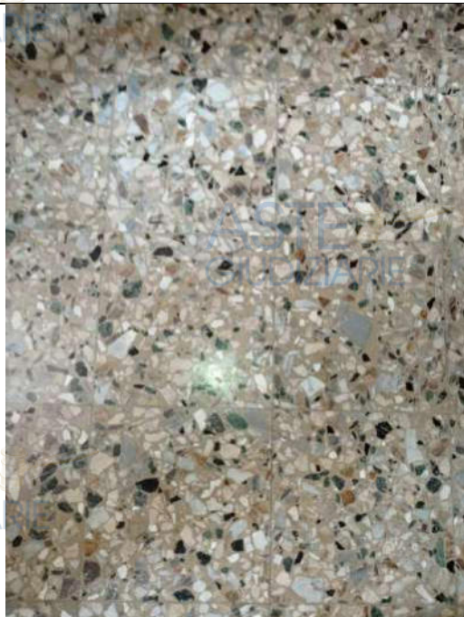
Foto 55. Particolare della tipologia di pavimentazione, in graniglia, presente nell'immobile, al piano Secondo
