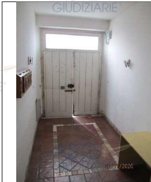
Foto 5. Particolare dell'androne scala del fabbricato
