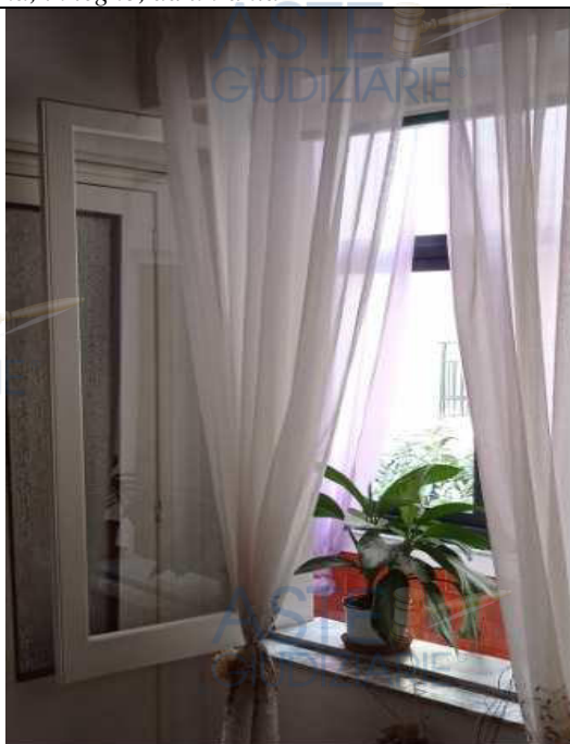
Foto 53. Particolare della tipologia di finestra, in legno, ad un'anta vetro singolo
