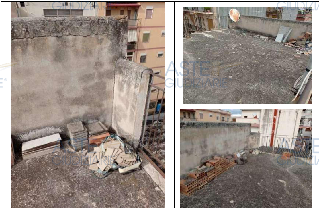
Foto 87, 88 e 89. Particolari dei danni rilevati sull'abbaino, dove si osservano parapetti crepati, assenza di impermeabilizzazione, nonché depositi di materiale inerte
