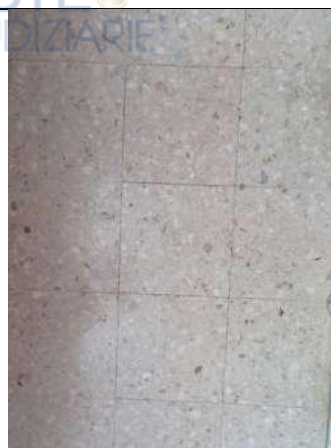
Foto 66. Particolare della tipologia di pavimentazione, in graniglia, presente sui balconi Sud e Nord-Est dell'immobile, al piano Terzo
