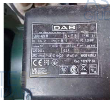
Foto 17 e 18. Particolare del motore dell'impianto autoclave
