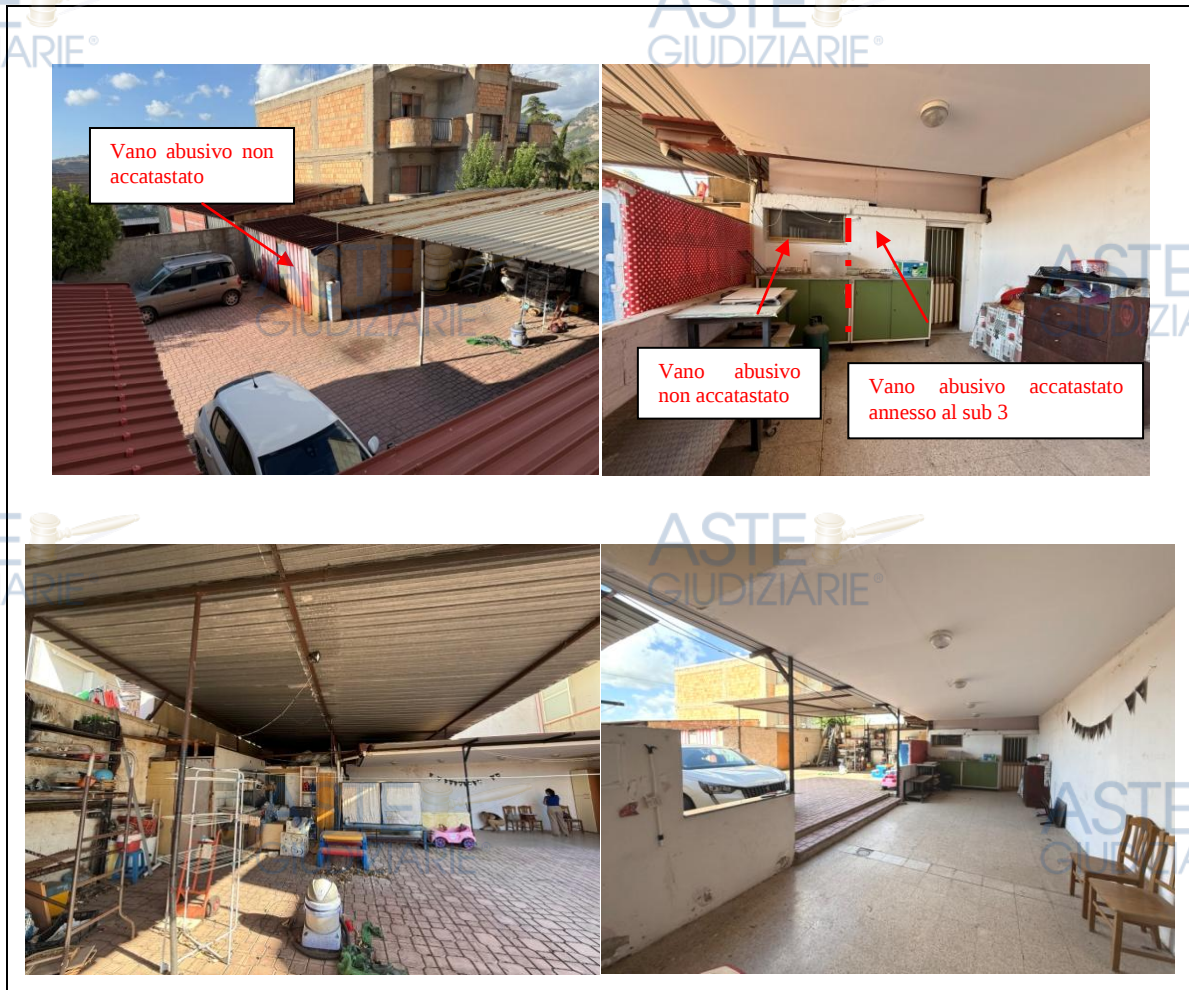
Fig.3- Vani deposito e tettoie privi di autorizzazione
