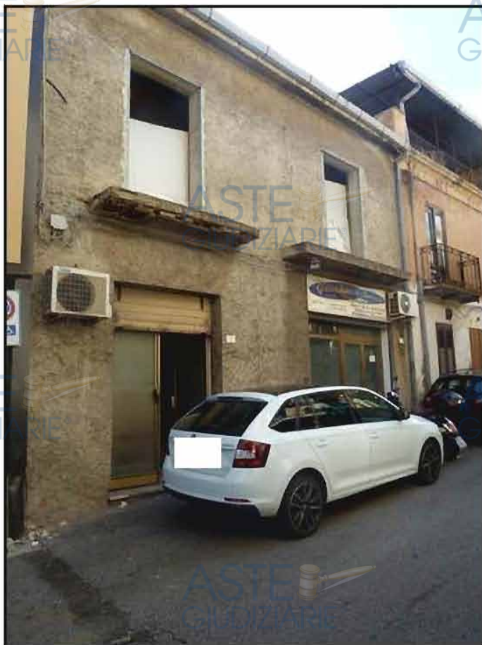
Foto 11 – ripresa del prospetto della particella 1896, ancora in corso di costruzione, lat via Umberto I°.
