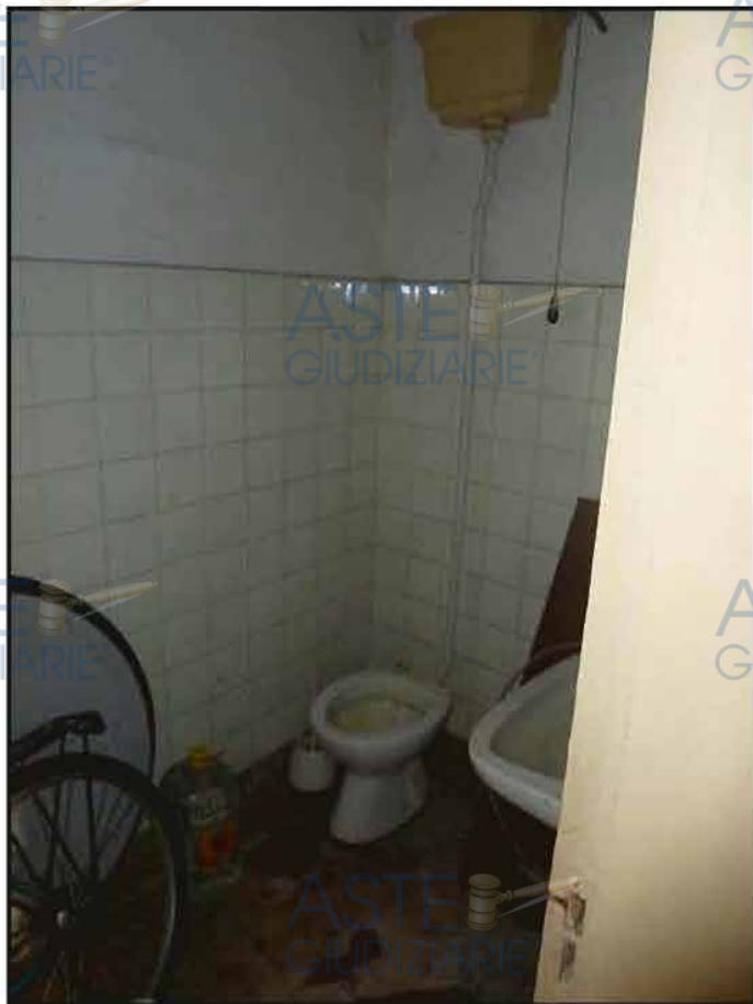
Foto 17 – ripresa del servizio wc del magazzino deposito attualmente sfitto – particella 1896 – Sub 2.
