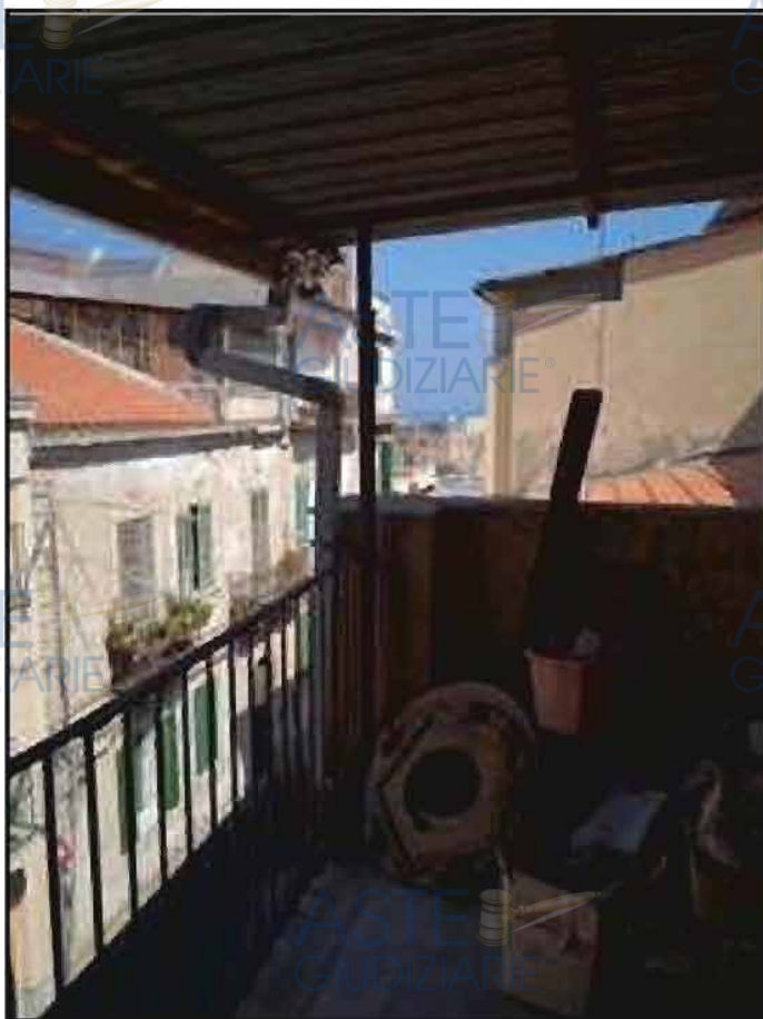
Foto 9 - ripresa della terrazza a livello del piano secondario della particella 1064 – Sub 3.
