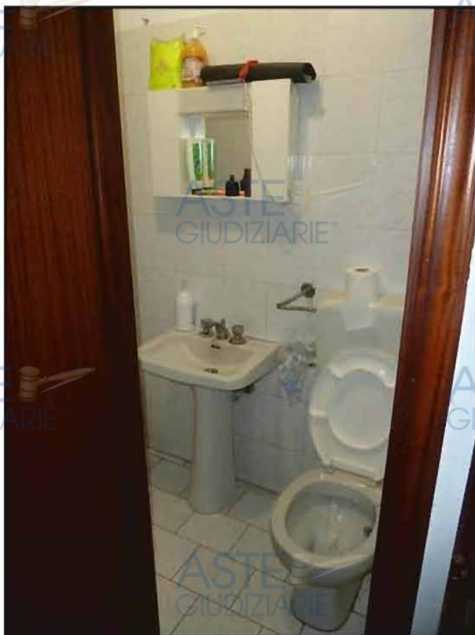
Foto 13 – ripresa del servizio wc del negozio condotto in locazione – particella 1896 – Sub 3.
