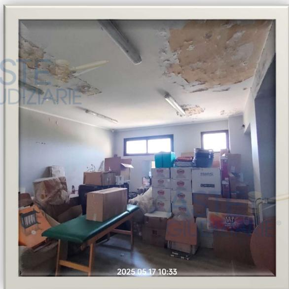
Foto n. 6: danni da infiltrazioni di acqua riscontrati all'interno dell'u.i.u. pignorata.
