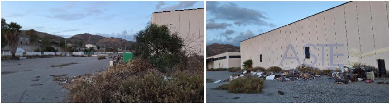
Vista dell'area libera vicino al capannone 2 (C)
