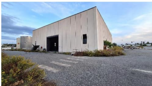
Vista del capannone C
