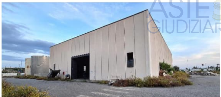
Capannone B _ Vista dall'esterno
