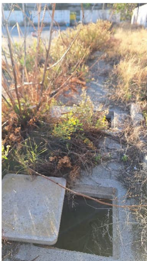
Pozzetti passaggio cavi
