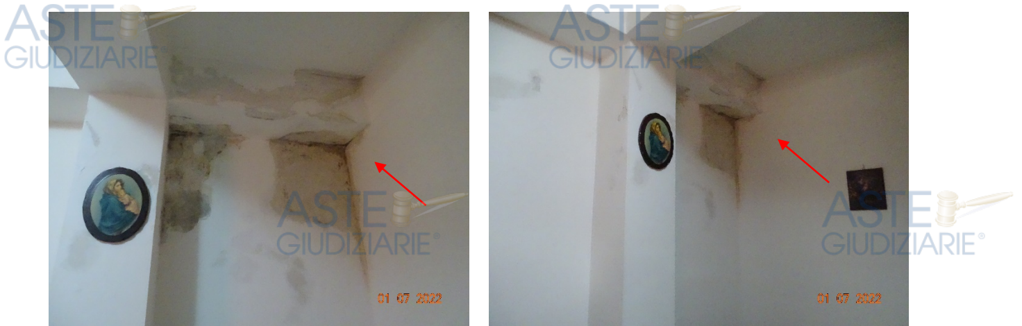
Figura 11: Danneggiamenti camera singola (pareti)
