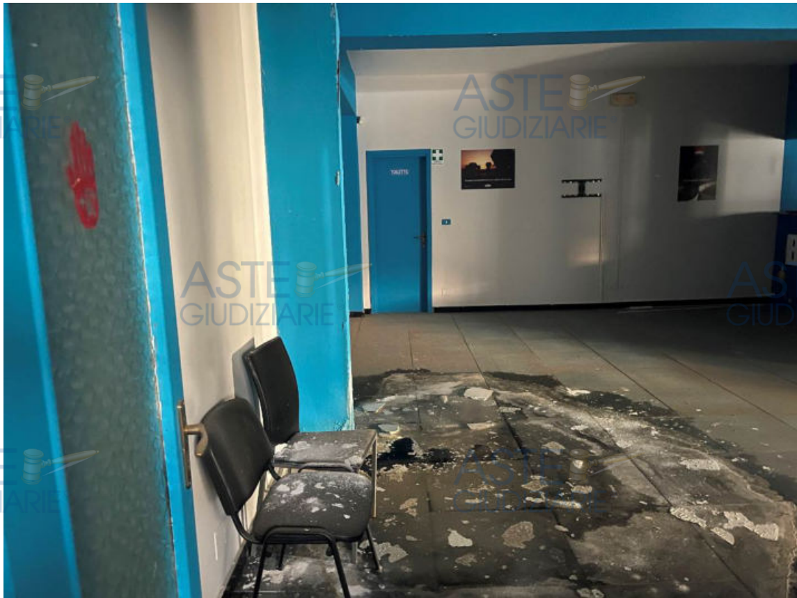
Foto 10-11 – Vista interna dell'unità immobiliare
