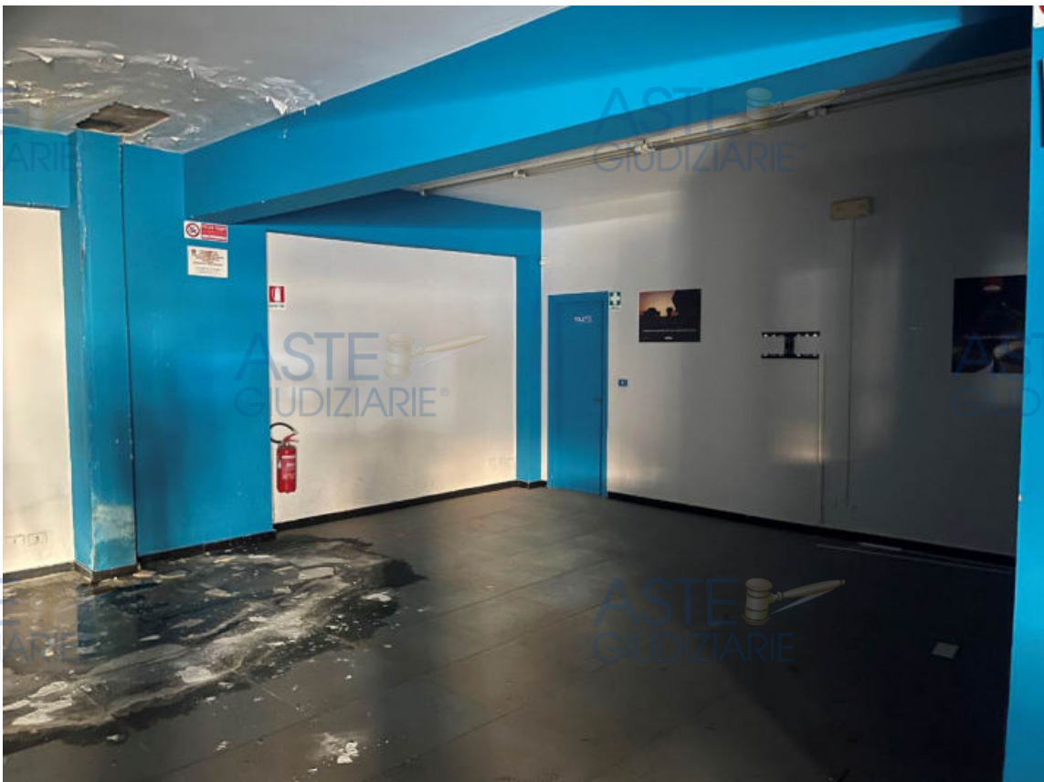
Foto 8-9 – Vista interna dell'unità immobiliare
