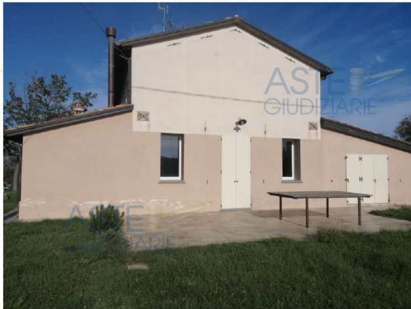
2_Mancata realizzazione del portico
