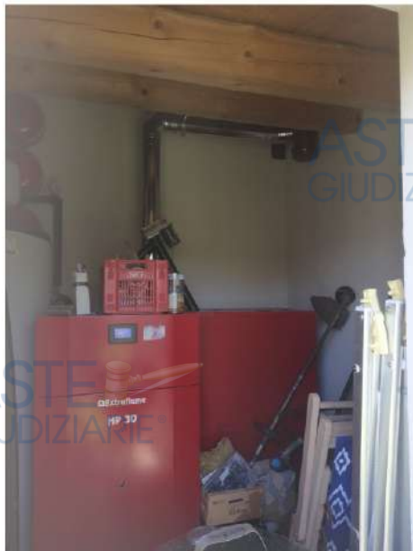
4_Diverso uso del locale ripostiglio utilizzato come centrale termica
