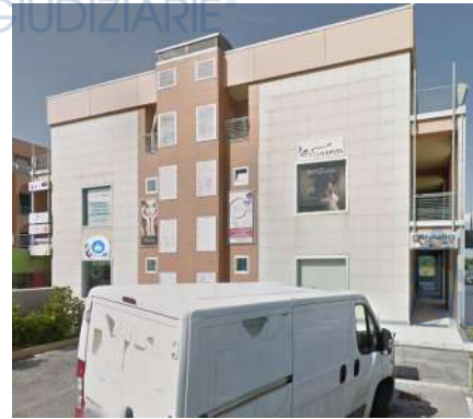
Prospetto laterale sinistro
