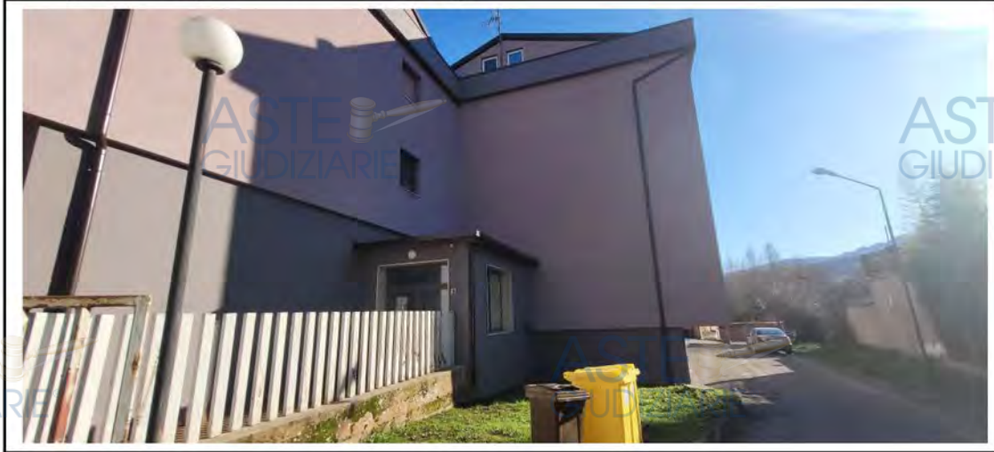
Immagine 7 – Particolare portone di accesso
