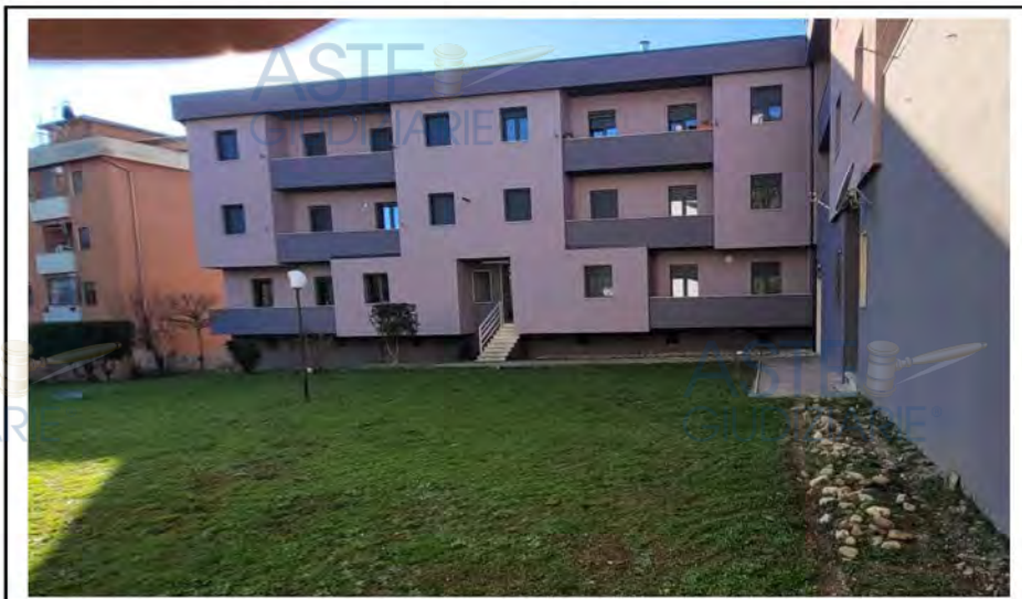
Immagine 9 – Prospetto laterale su area pertinenziale
