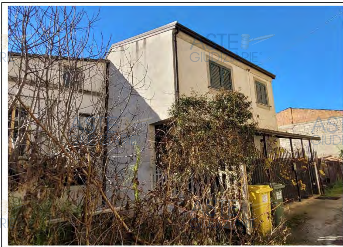
Immagine 13 – Prospetto laterale su fabbricato in aderenza
