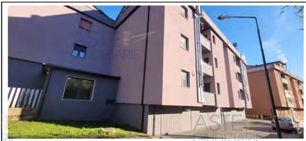
Immagine 8 – Prospetto laterale su accessi garage
