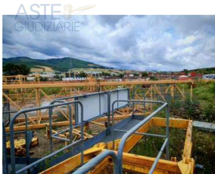
Foto n. 23 – Gru a torre FM 1355 TLX
