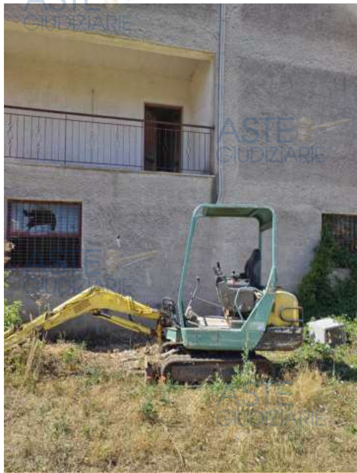
Foto n. 29 – Mini escavatore Amman Yanmar mod. B15BR
