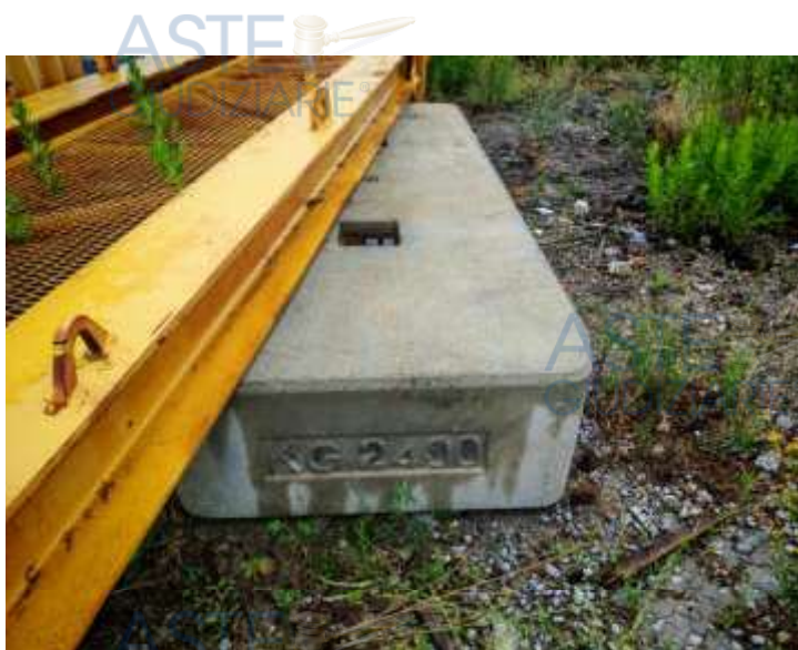
Foto n. 24 – Gru a torre FM 1355 TLX
