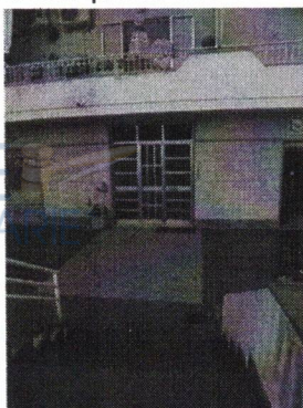
Portone ingresso alloggi
