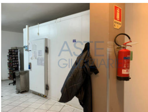
Figura 185 - Autogrill: Celle frigorifere
