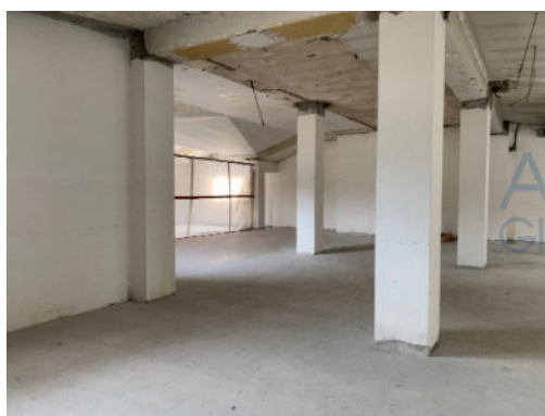
Figura 150 - Deposito piano primo
