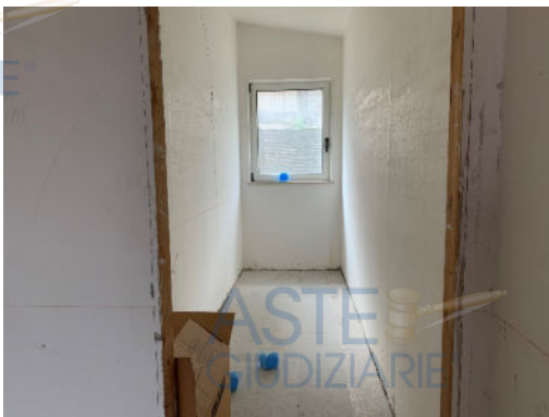
Figura 151 - Deposito piano primo
