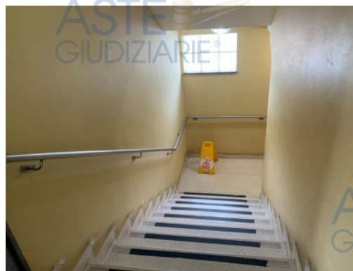
Figura 176 - Autogrill: Scala collegamento PT-PS1
