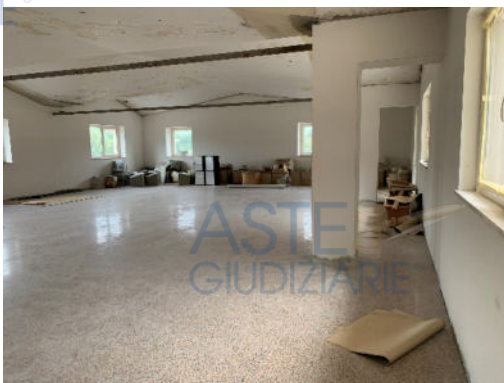
Figura 153 - Deposito piano primo
