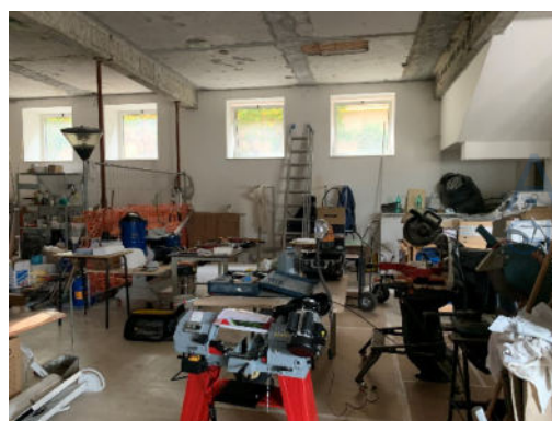
Figura 144 - Deposito piano terra
