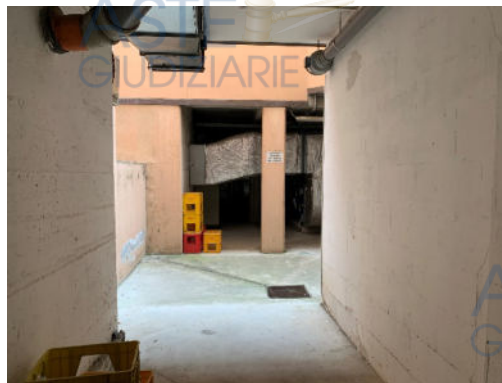
Figura 116 - Accesso zona impianti
