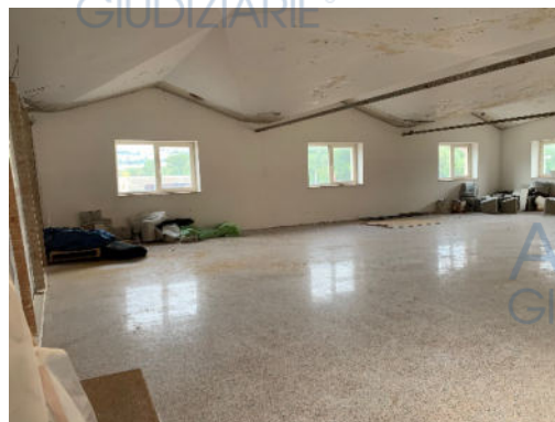
Figura 154 - Deposito piano primo
