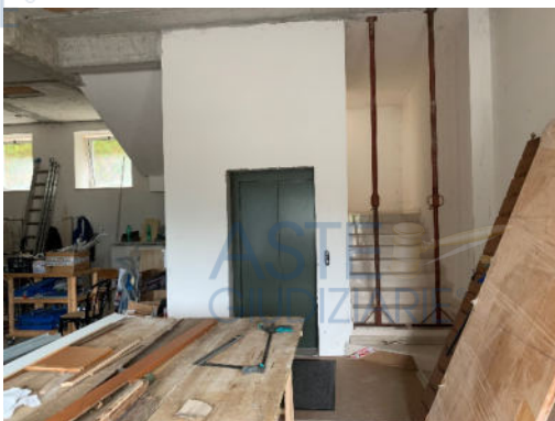
Figura 147 - Deposito piano terra
