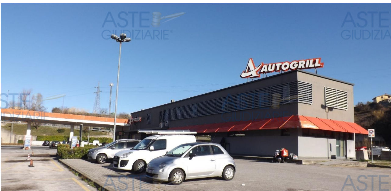
Foto 6 Prospetto principale (Gennaio 2025)
