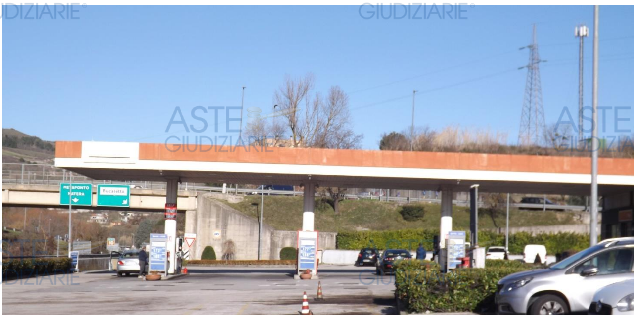
Foto 5 Tettoia con colonnine di erogazione (gennaio 2025)
