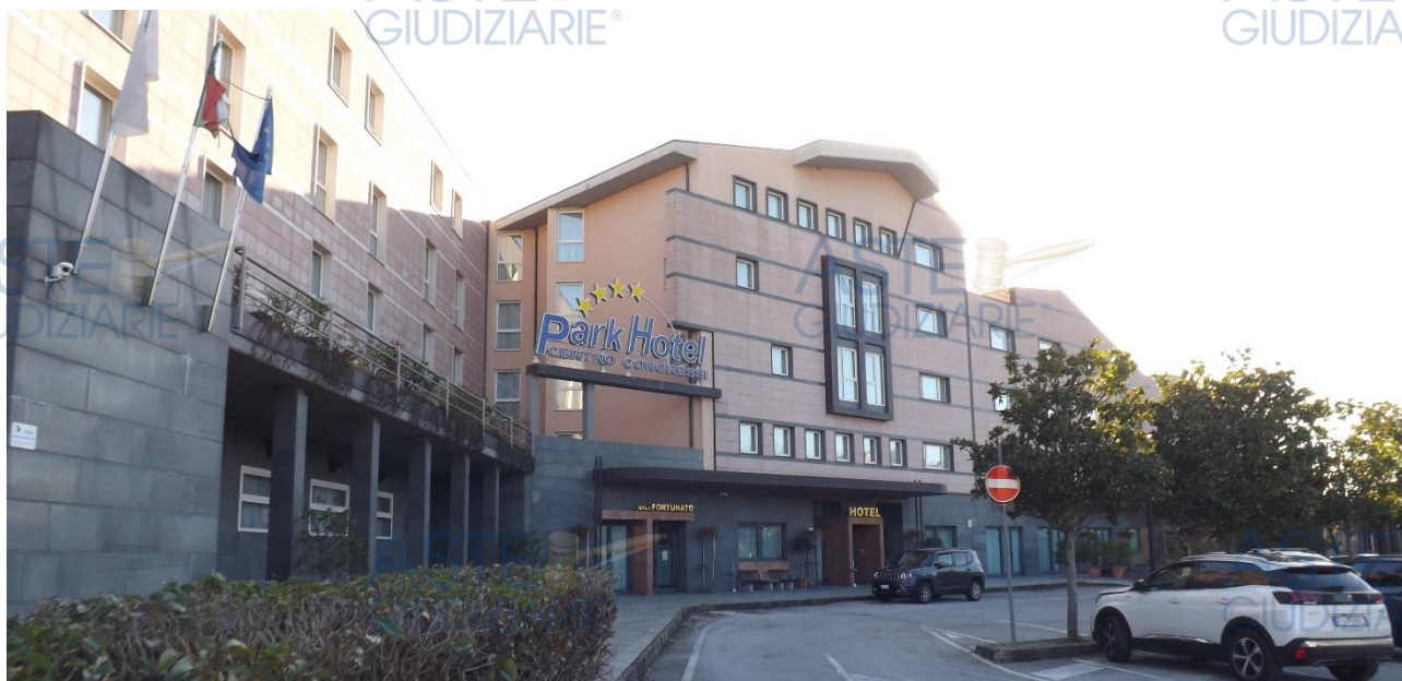
Foto 2 Prospetto Principale (gennaio 2025)
