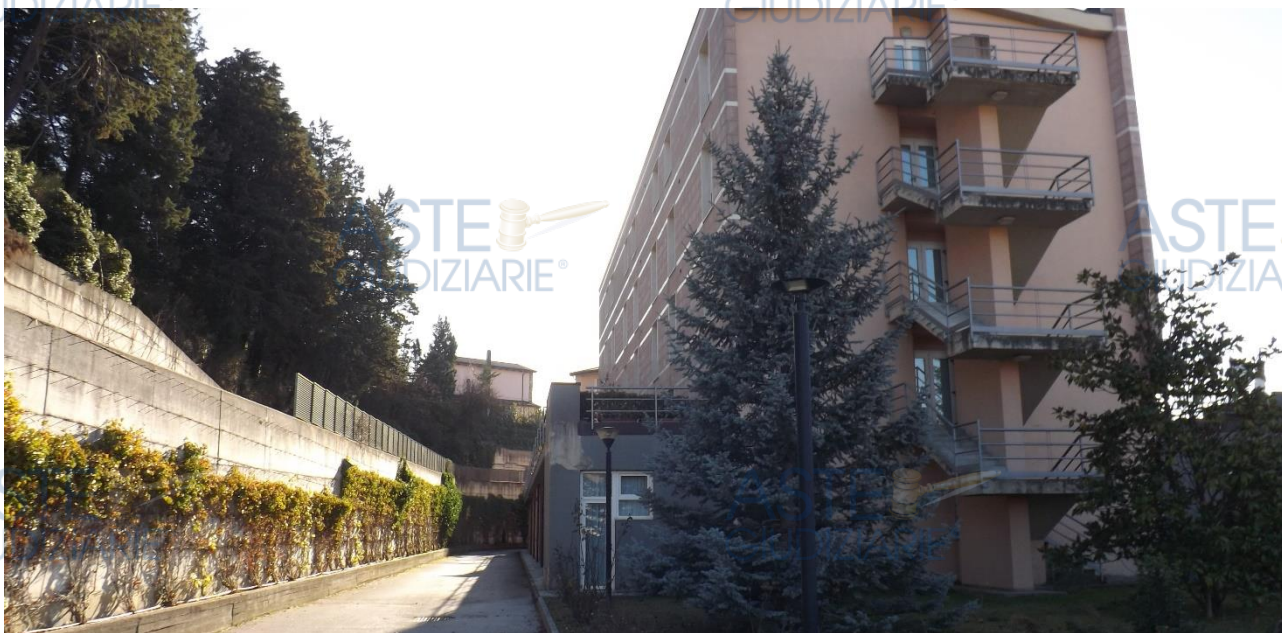
Foto 3 Prospetto laterale (gennaio 2025)
