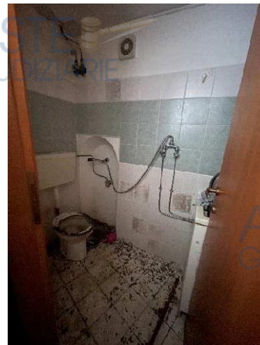
Figura 26: Vista del WC
