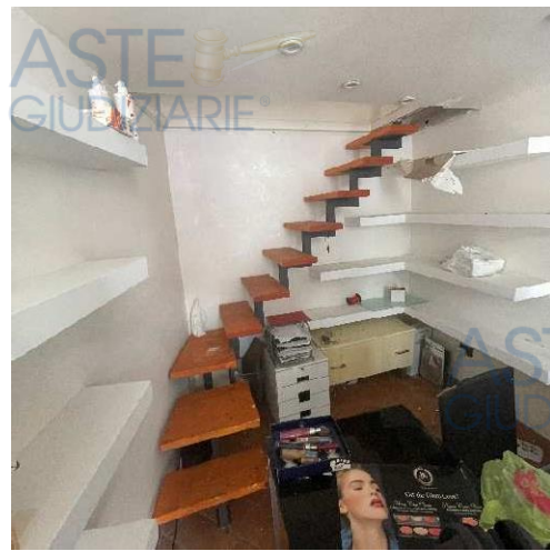
Figura 24: Vista scala accesso soppalco
