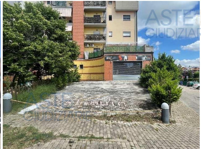
Figura 5: Vista fabbricato da Via Isabella Morra
