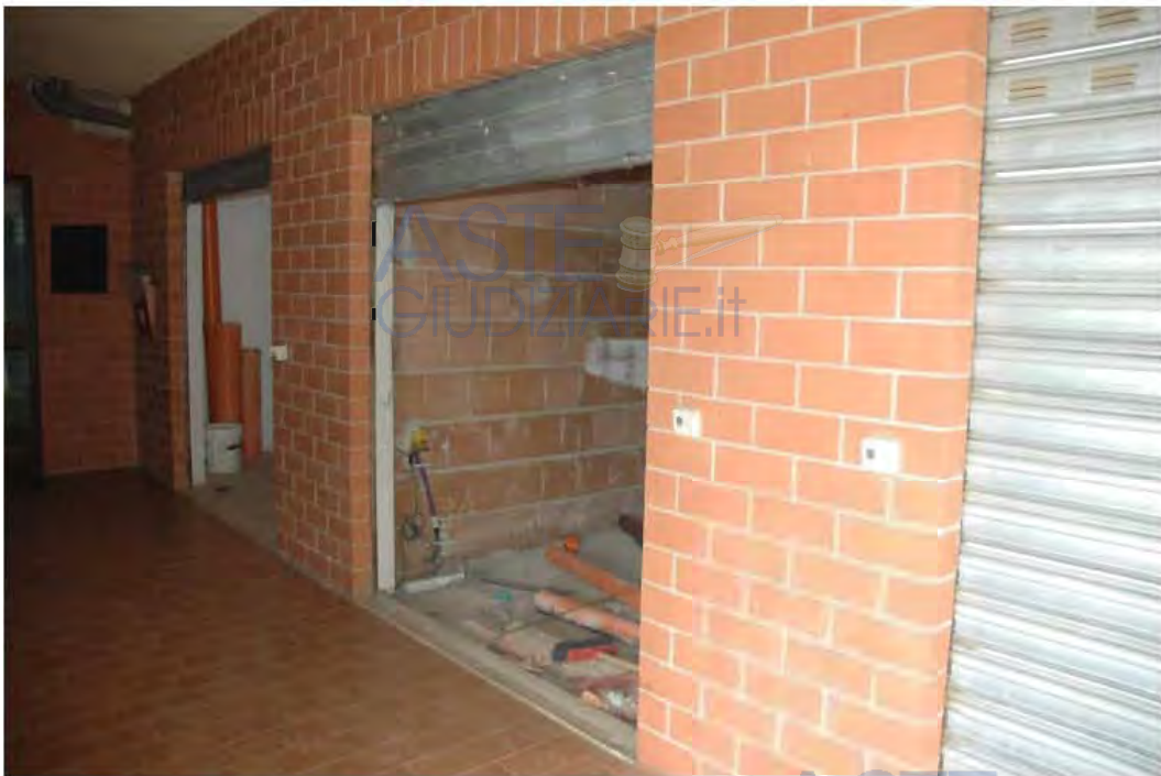
Il locale deposito ancora in fase di costruzione suddiviso da un tramezzo.
