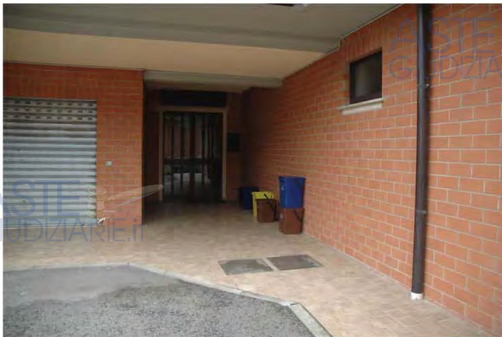
Il portone d'ingresso del piano terra.
