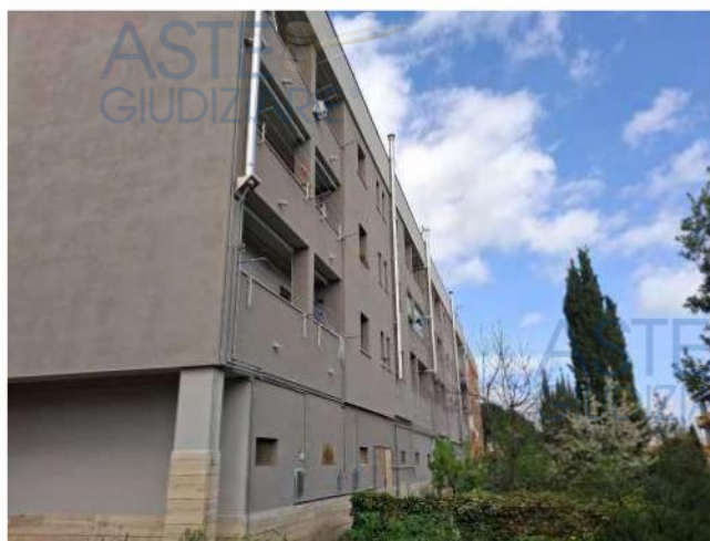
Vista posteriore del fabbricato
