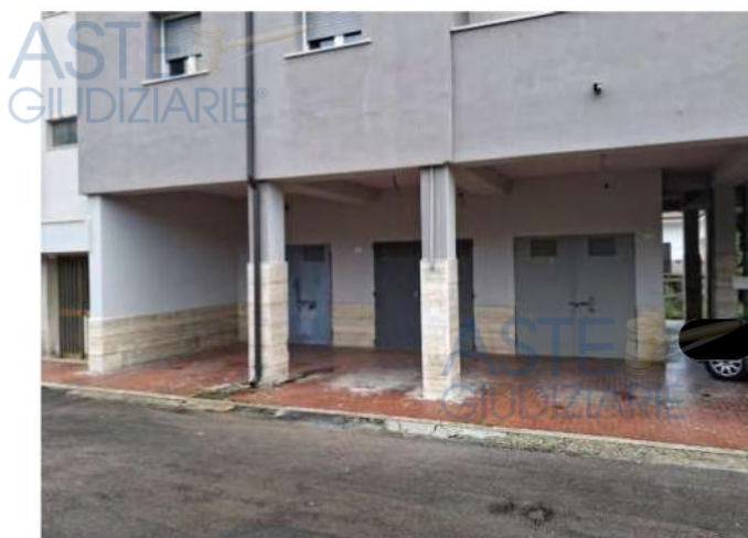
Vista del portico di accesso al garage
