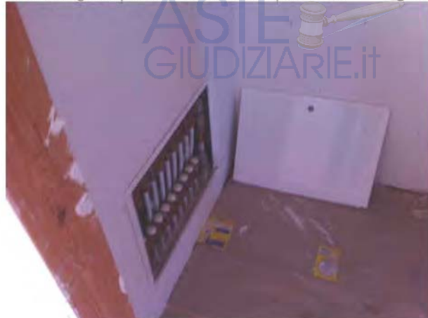
Vista dettaglio impianto riscaldamento a pavimento
