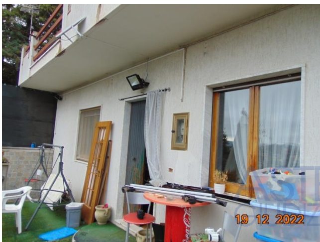
Ingresso abitazione - Visto dall'esterno
