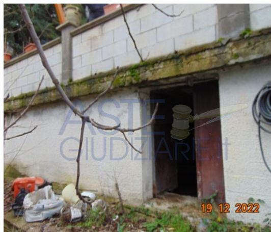
Ingresso cantina - Visto dall'esterno
