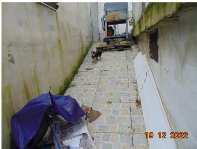
Camminamento ingresso cantina
