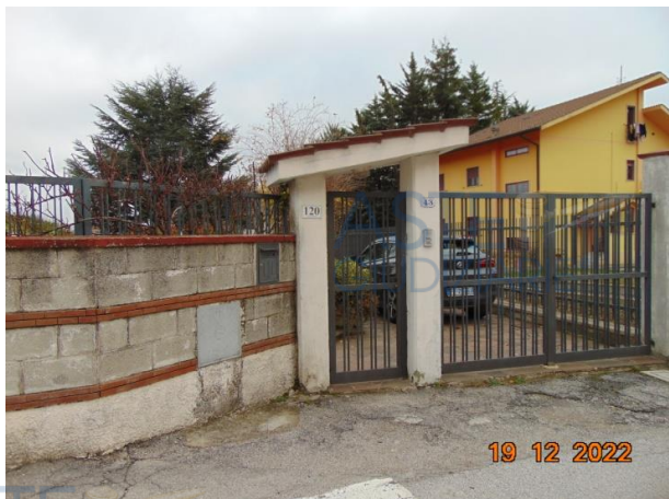
Ingresso (particolare: cancello esterno)
