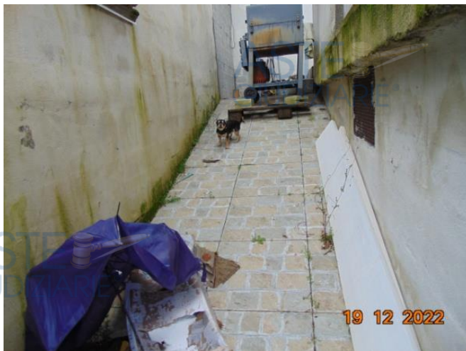
Camminamento ingresso cantina
