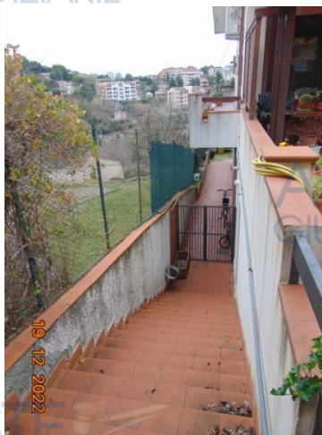
Ingresso - particolare scala
