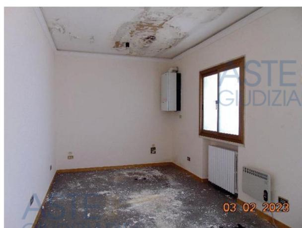
**Foto n. 4 – Interno (particolare infiltrazione)**
