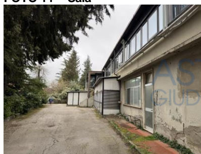
FOTO 14 - Prospetto a valle
