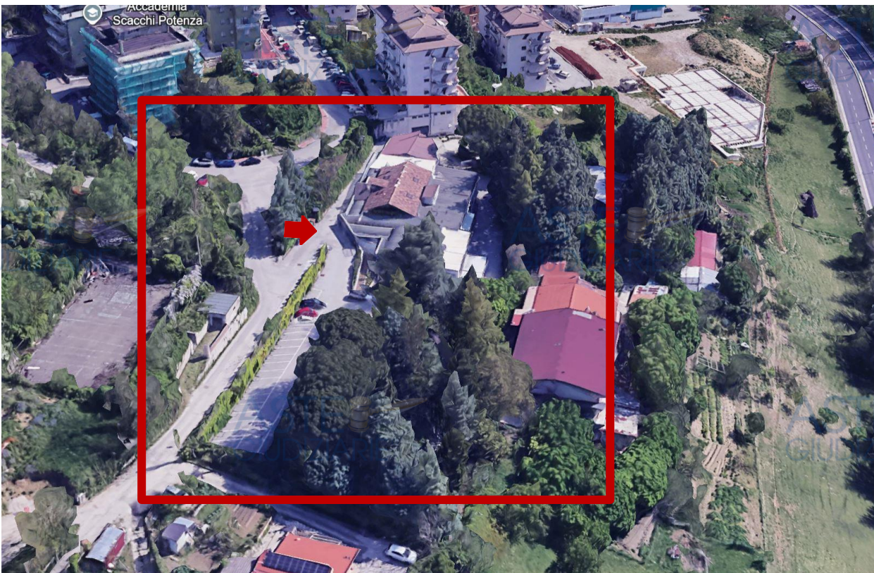
Figura 5 – Foto aerea con individuazione del complesso immobiliare.
