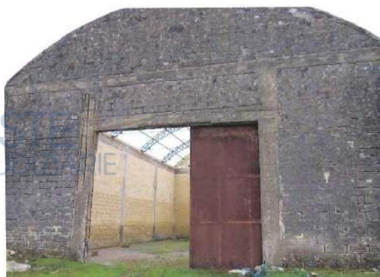
Successivamente agli interventi di manutenzione e ristrutturazione effettuati, per effetto con D.I.A. prot. n.°2782 del 25.3.2011, l'immobile è stato oggetto di realizzo di nuova copertura, in pannelli di lamiera zincata, intonacatura interna ed esterna, ripristino di muratura anteriore, ripristino di pavimentazione in getto di cemento, fornitura di scossaline e pluviali, interventi che lo hanno portato in uno stato di decoro ed utilizzabilità.
