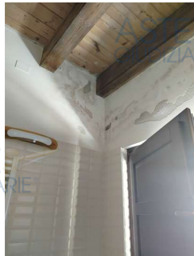
Parete Bagno al piano primo
