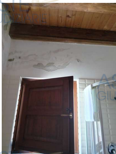
Parete Bagno al piano primo
