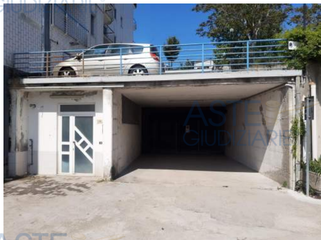
Accesso ai garage dal piazzale
