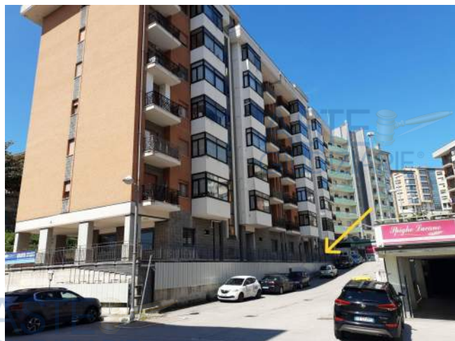
Vista del fabbricato da via Consolini
