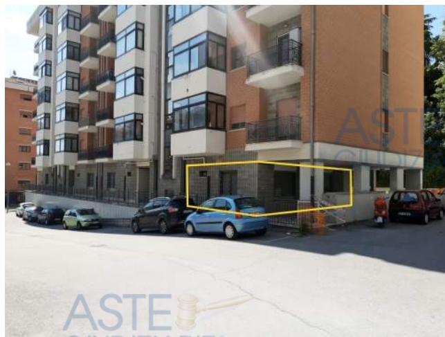
Vista del fabbricato da Nord
