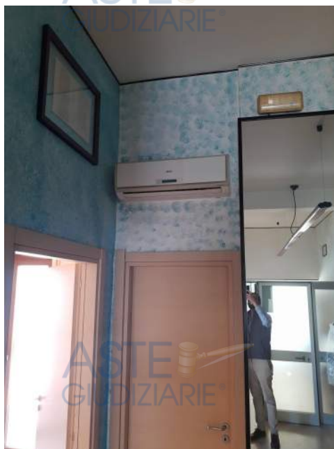
Vista dell'ambiente di disimpegno (sistema aria condizionata)
