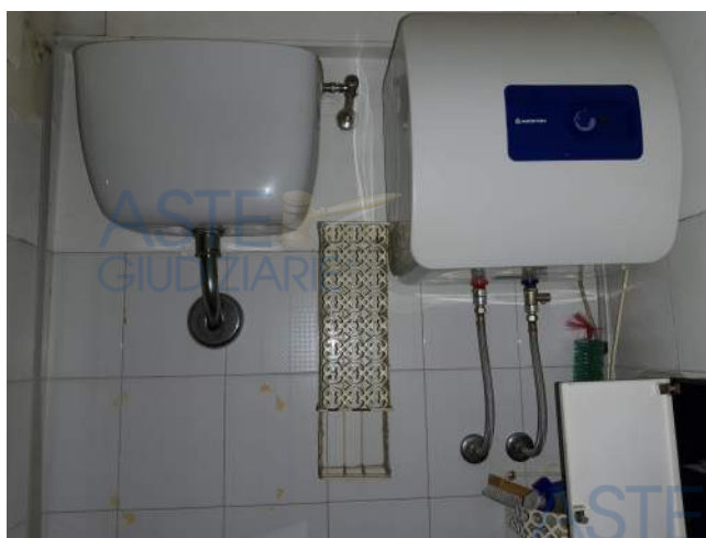
Vista del WC
