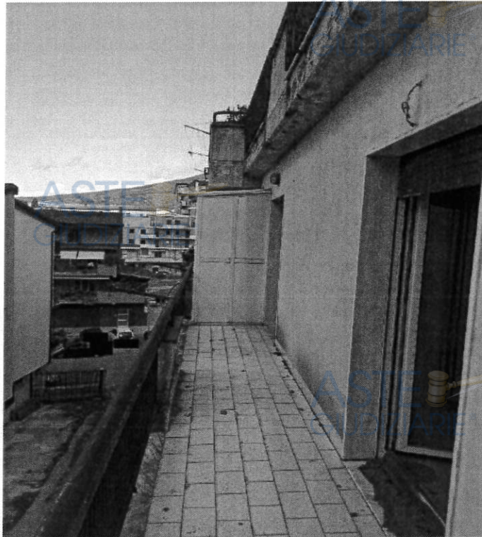
FOTO N.12: balcone prospetto sud-ovest appartamento piano 3
