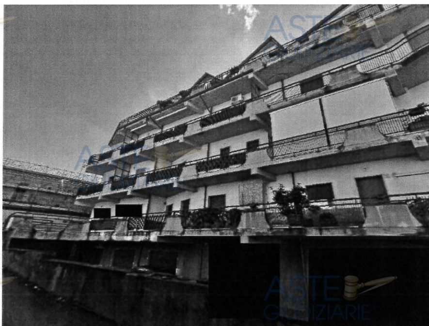
FOTO N.1: prospetto nord-est fabbricato condominiale
