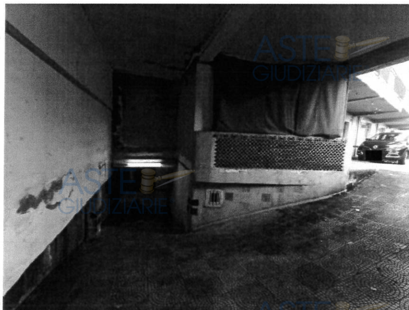
FOTO N.3: rampa interna accesso piano s1
