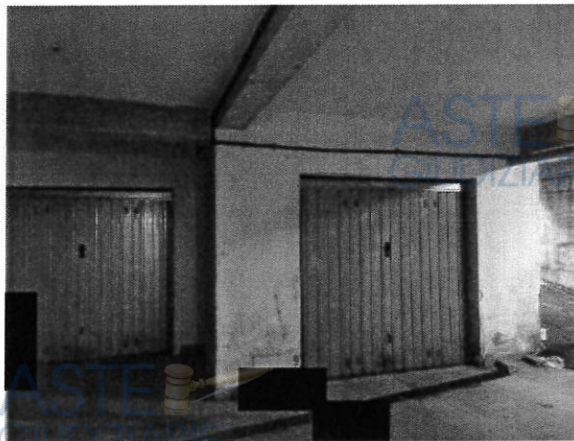
FOTO N.13: porta locale deposito piano s1
