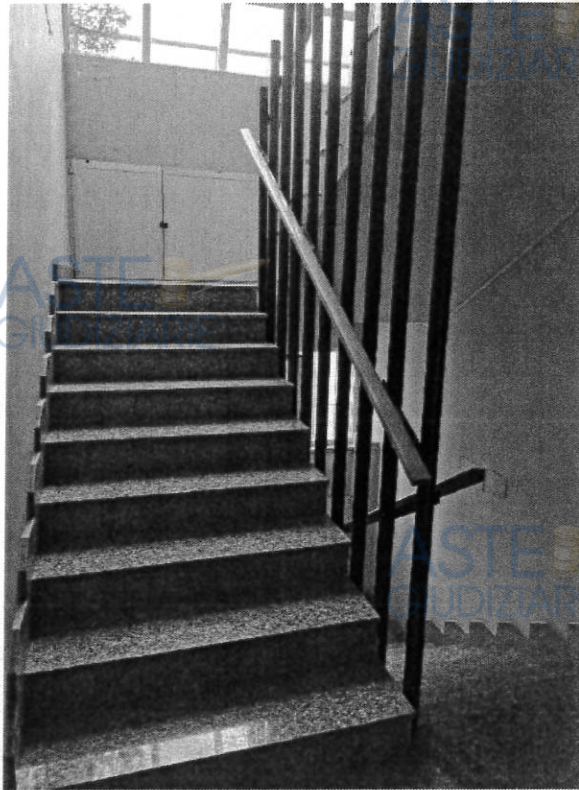
FOTO N.4: vano scala condominiale piano 3
