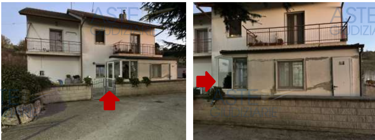
INGRESSO AL PIANO TERRA – LOTTO N. 1- L1
