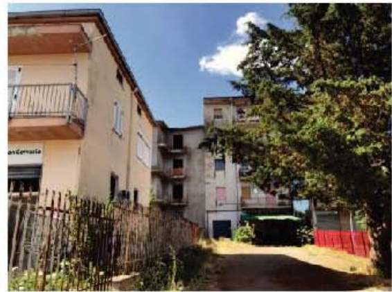
prospetto laterale destro
