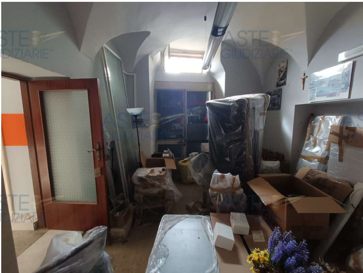
Figura 5 – Interno locale Via Floriano Del Zio, n. 71-73.
