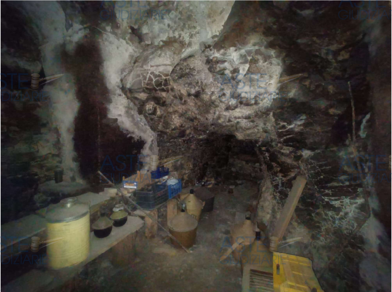
Figura 2 – Interno locale Deposito, Via Floriano Del Zio, n. 75.
