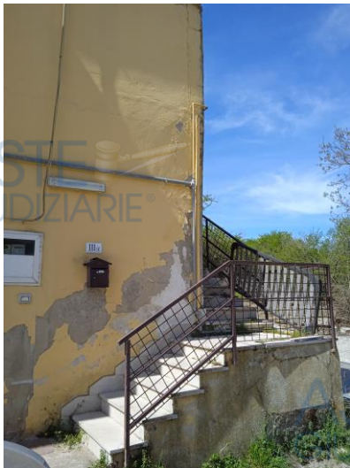
Scala di accesso
