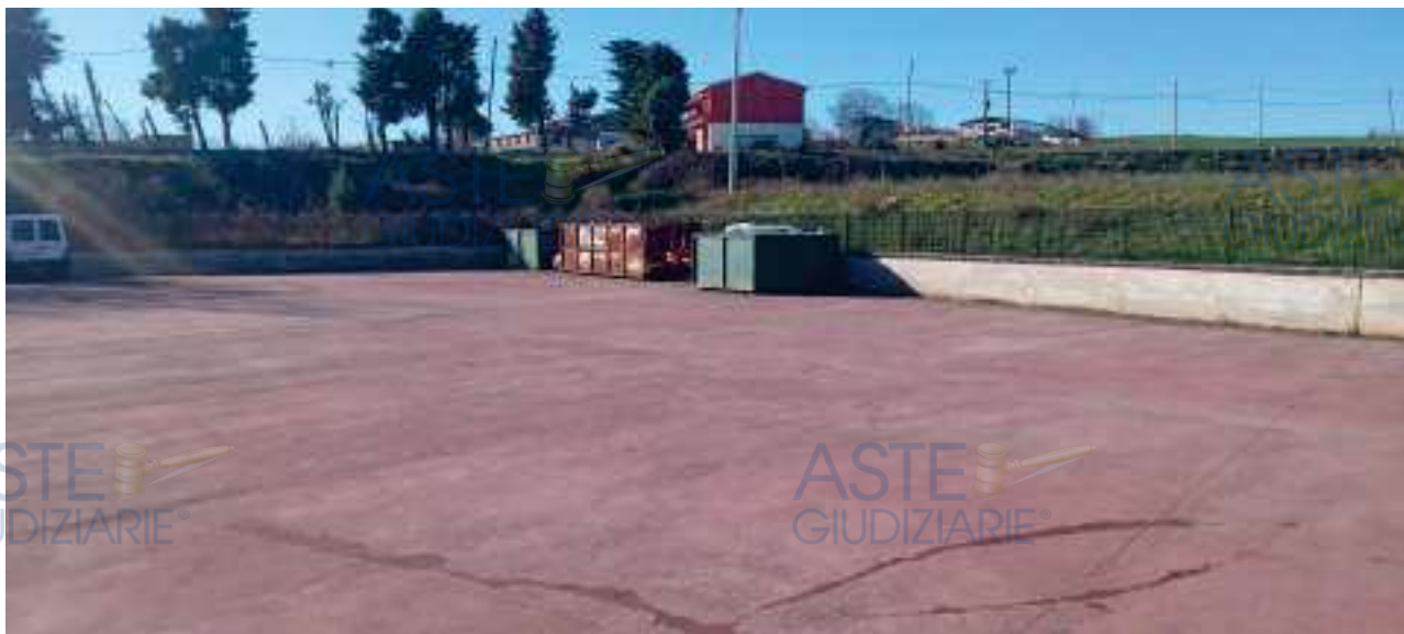
Piazzale lato Sud-Ovest (sub4)
