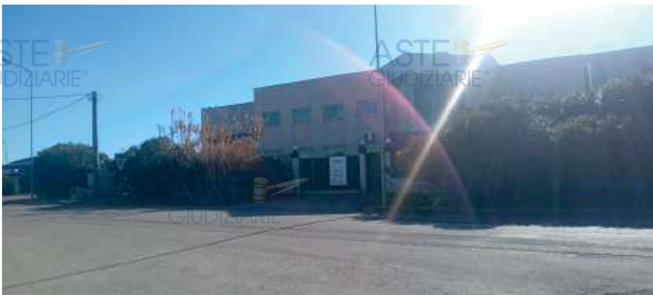
Vista da strada ingresso bar e corte sub 2
