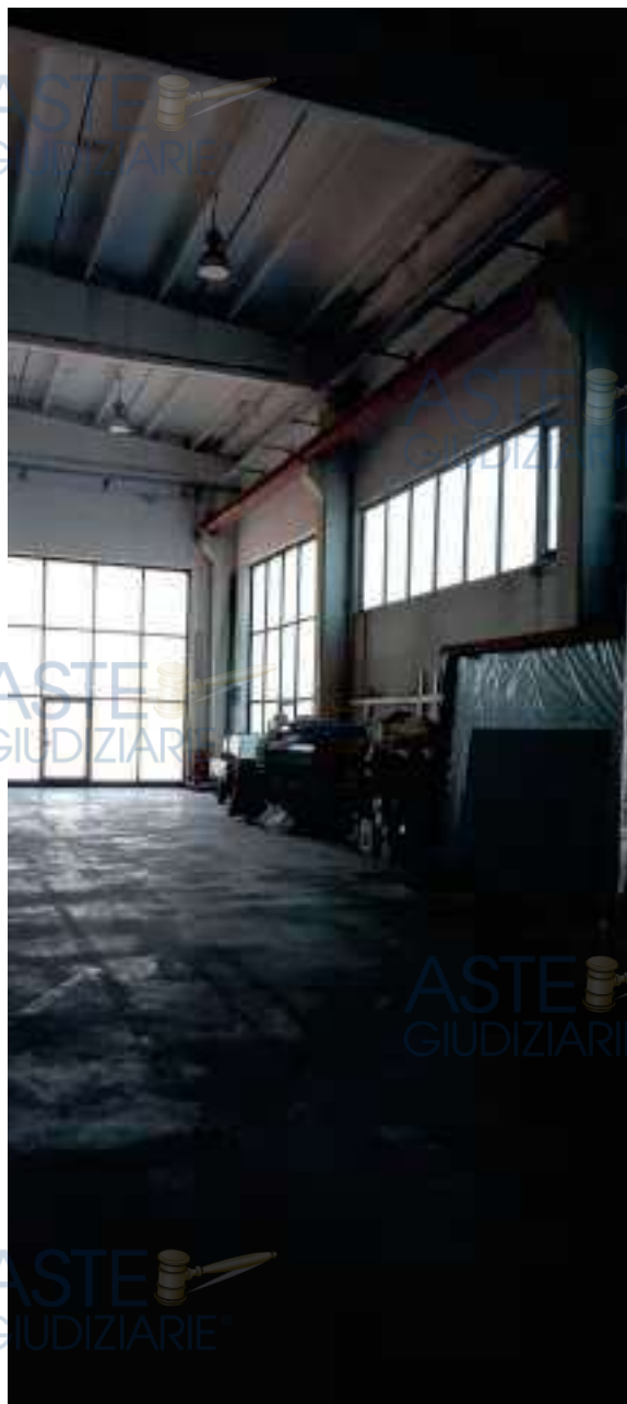
Capannone lato Nord-Ovest
