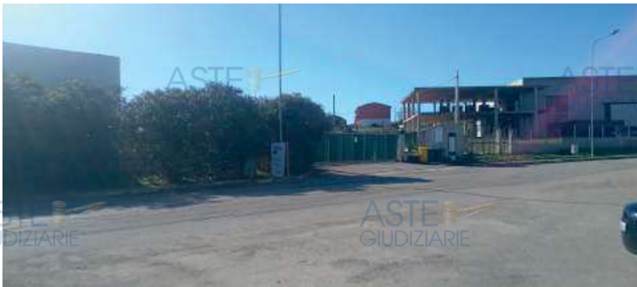
Vista da strada ingresso piazzale (sub4)
