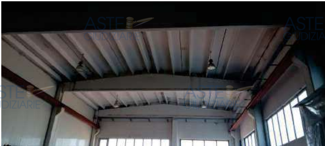
Capannone lato Nord-Ovest
