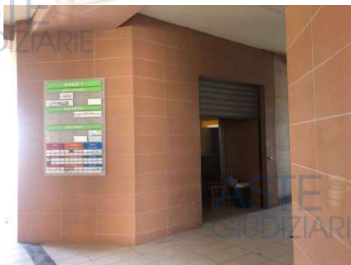
Ingresso al lotto 1
