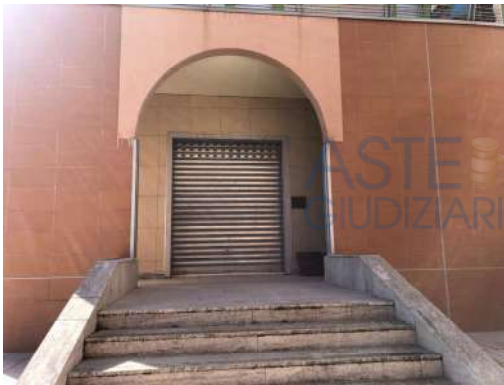
Ingresso al lotto 7
