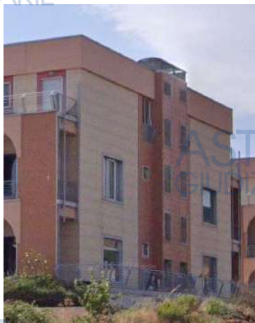
Prospetto laterale destro
