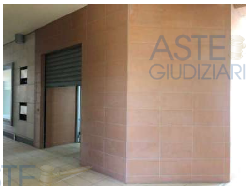
Ingresso al lotto 16
