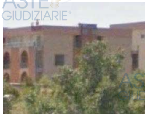
Prospetto laterale destro
