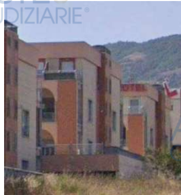
Prospetto laterale destro
