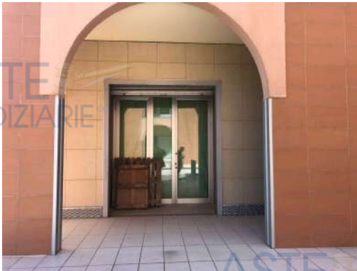
Ingresso al lotto 2
