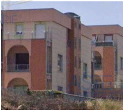
Prospetto laterale destro
