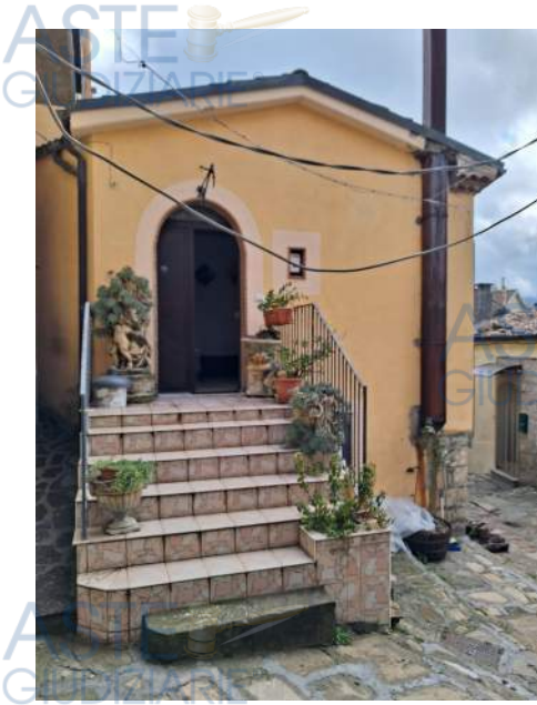
Vista del fabbricato - facciata nord
