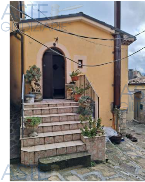
Vista del fabbricato - facciata nord
