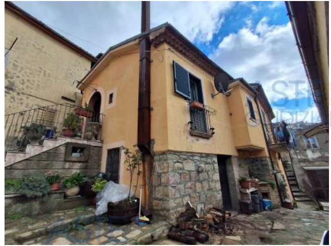
Vista del fabbricato da Vicolo III di Monte
