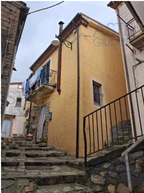
Vista del fabbricato da intersezione Vicolo II e III di Monte
