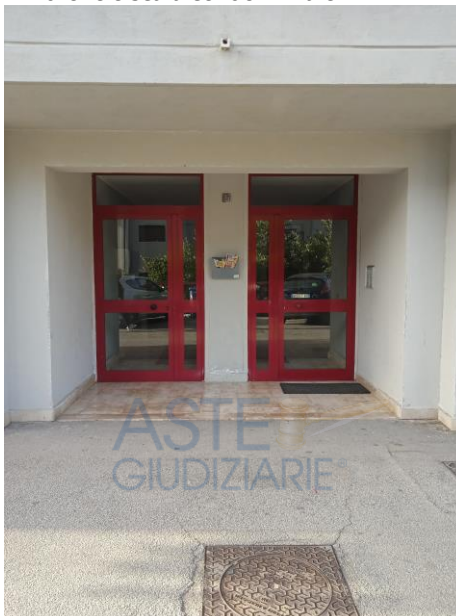
Androne e scala condominiale
