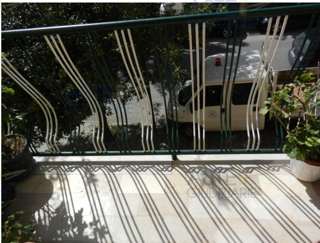
(Particolare balcone) FOTO 32
