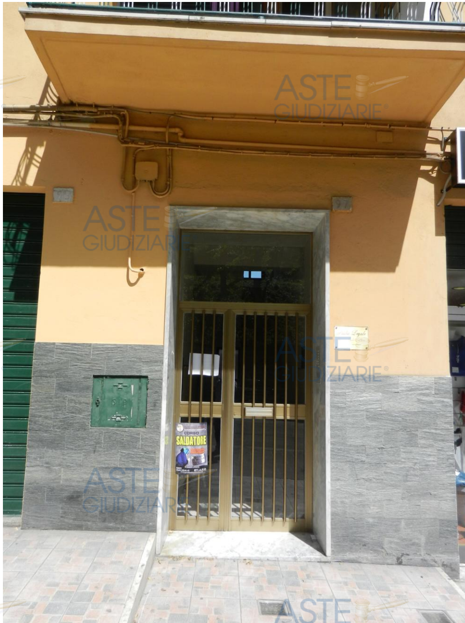
(Ingresso Condominio) FOTO 1
