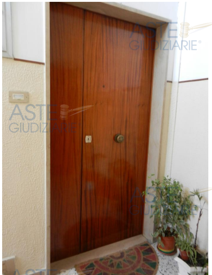
(Portone d'ingresso appartamento) FOTO 6
